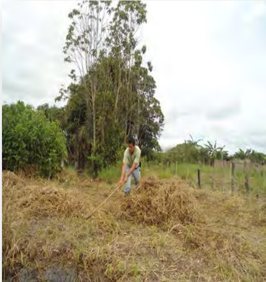
IMAGEN N°01: LIMPIEZA DEL LUGAR
