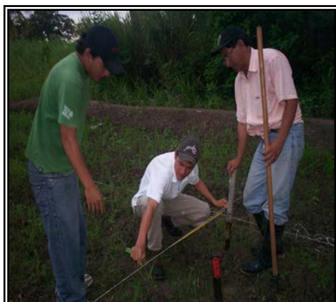
Foto N° 07: Demarcación de la parte delantera del terreno.
