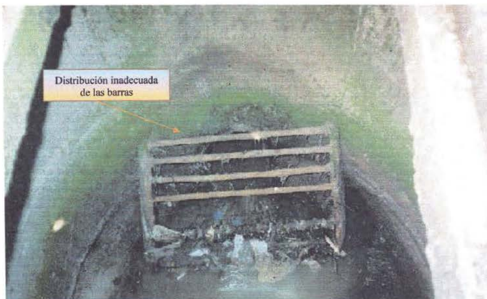
Foto 02. Cámara de rejas existente en la PTAR - Soritor
