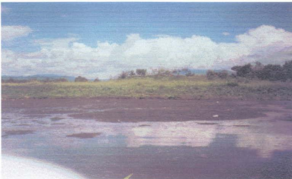
Foto 04. Acumulación de lodos en espacios muertos de las lagunas
