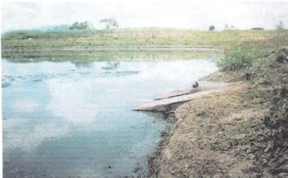
Foto 01. Ingreso del AR a una de las lagunas de estabilización de la PTAR - Soritor
