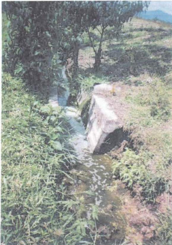
Foto 07. Descarga del agua residual a la salida de la PTAR-Soritor.
