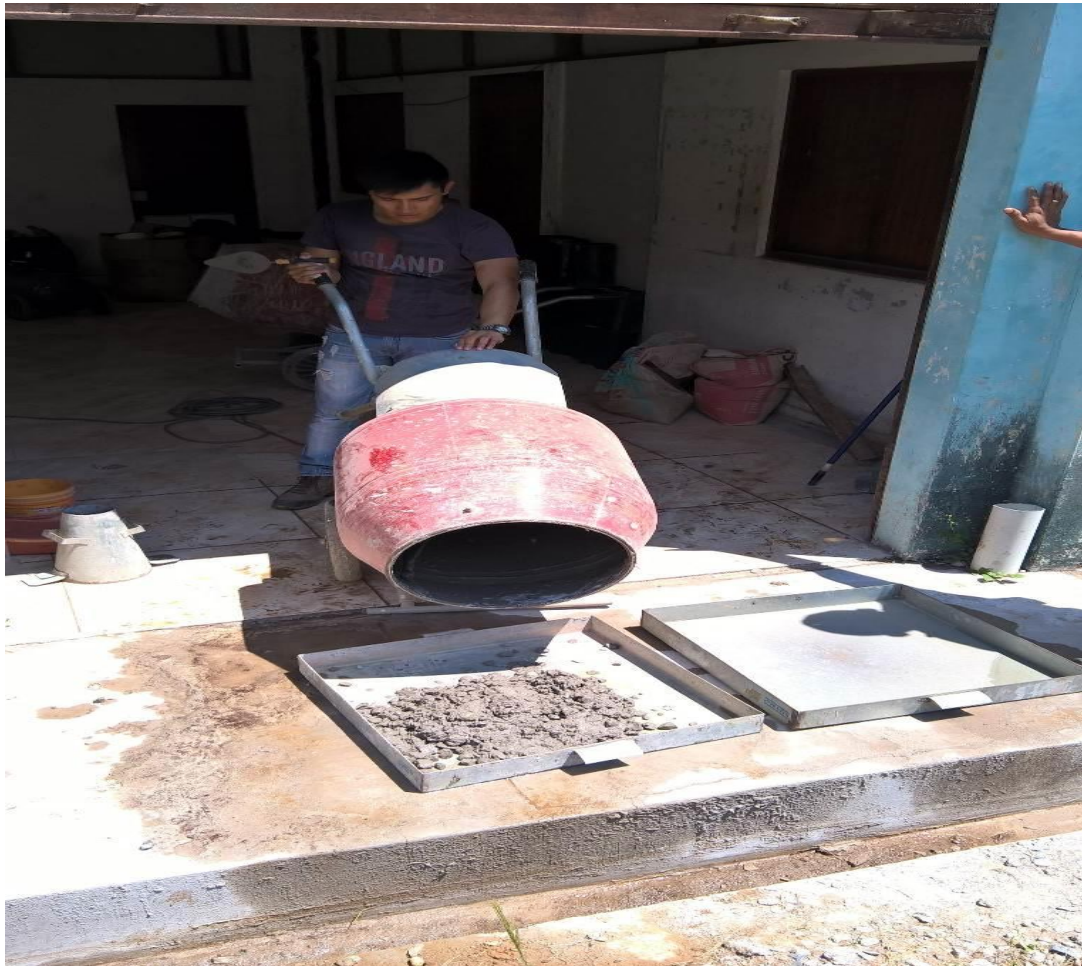
Fotografía N°15 mezclado y vaciado de los materiales
