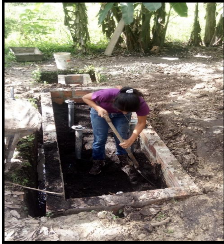
Foto N° 07: Colocación de tierra negra en el humedal artificial.
