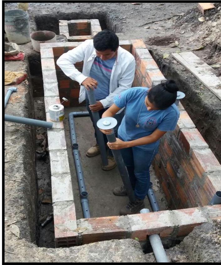
Foto N° 05: Colocación del sistema de drenaje o recolección y ventilación.
