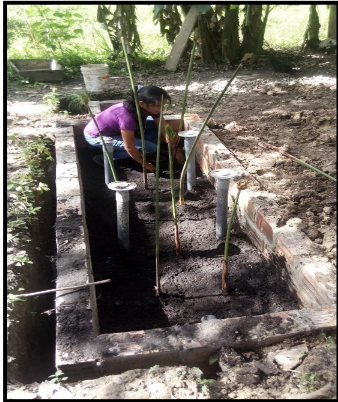
Foto N° 10: Colocación de arena en el humedal artificial.
