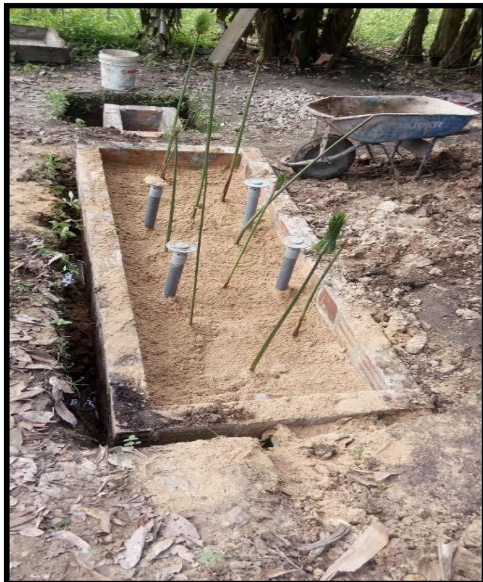
Foto N° 10: Colocación de arena en el humedal artificial.
