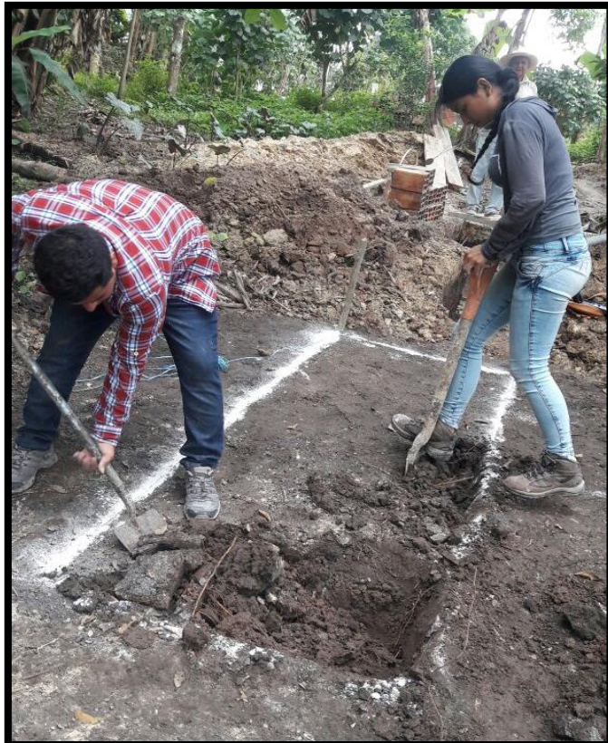
Foto N° 02: Inicio de la excavación de zanja para el humedal artificial.
