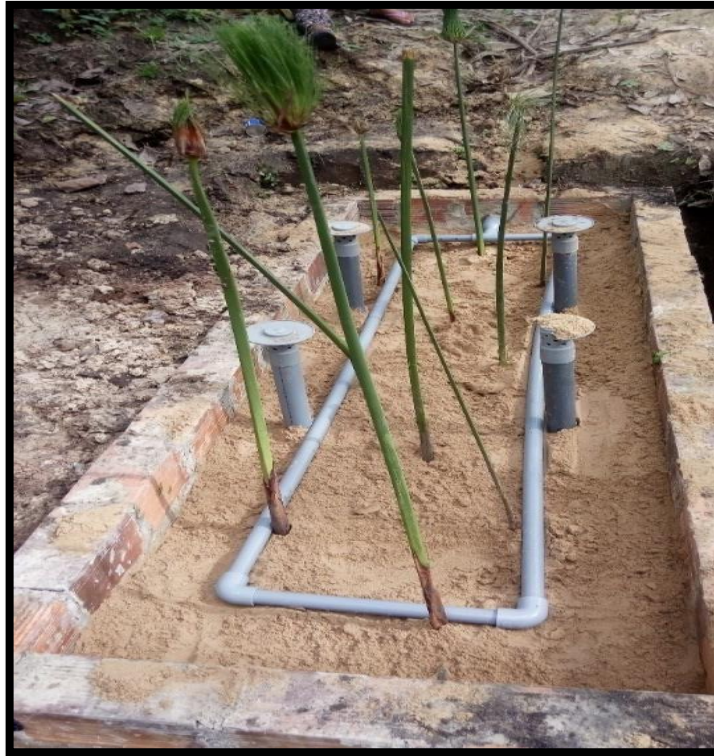
Foto N° 11: Instalación de tuberías de conducción de agua residual al humedal artificial.
