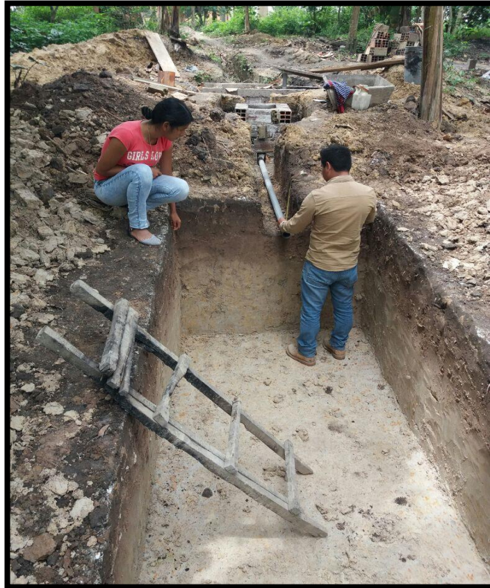
Foto N° 03: Finalización de la excavación de zanja para el humedal artificial.
