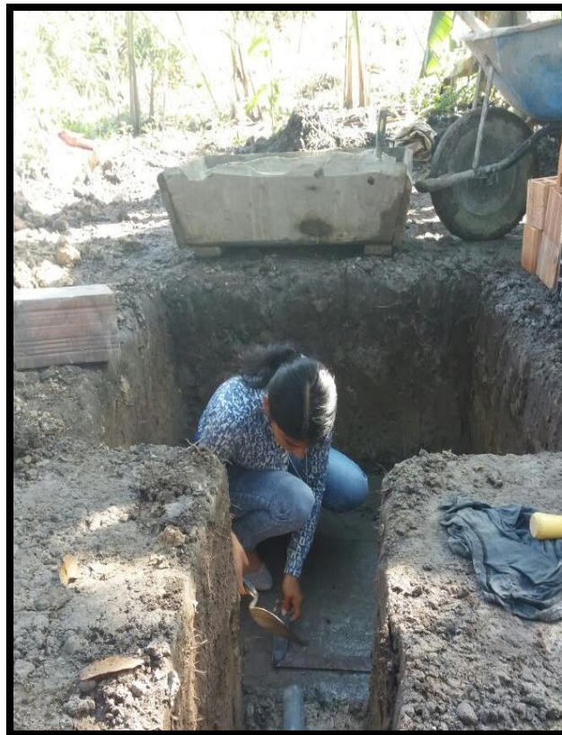
Foto N° 14: Construcción de cajas de registro.
