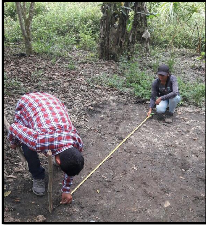
Foto N° 02: Inicio de la excavación de zanja para el humedal artificial.
