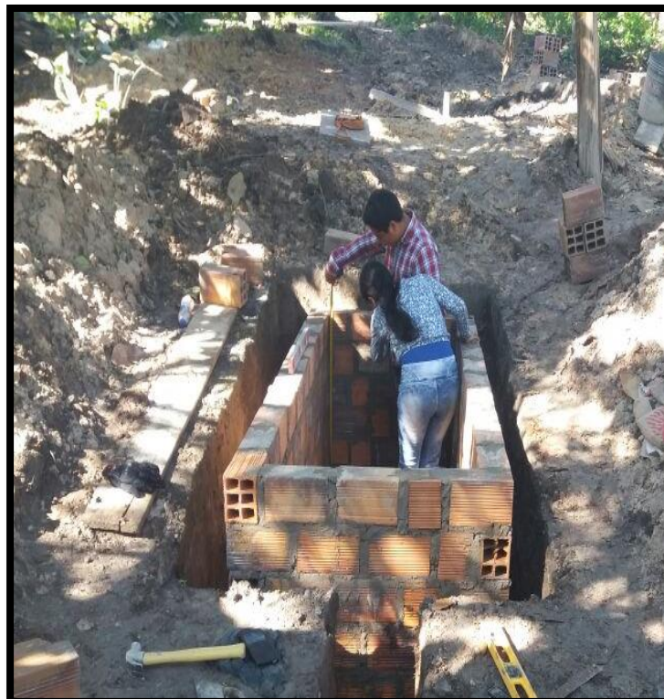
Foto N° 04: Construcción de las paredes del humedal artificial.
