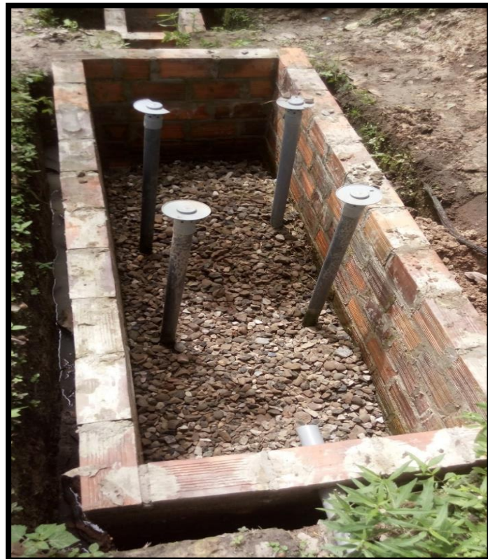
Foto N° 06: Colocación de grava en el humedal artificial.
