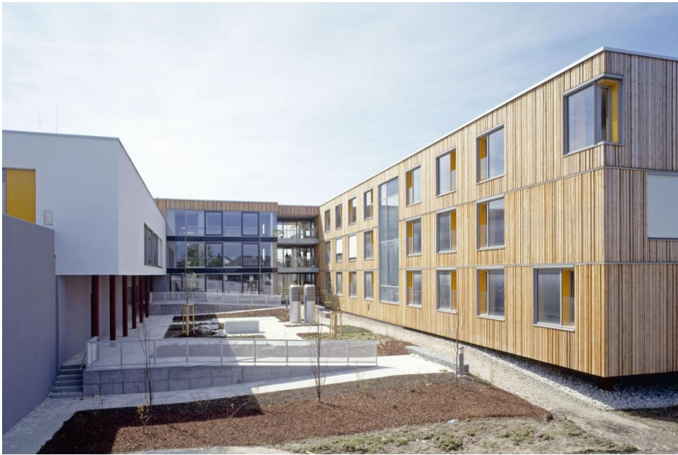
VISTA DE UN PATIO CENTRAL
