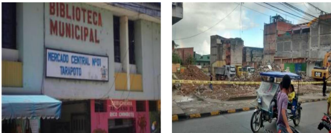
Imagen 2: Demolición del mercado y biblioteca municipal de Tarapoto
