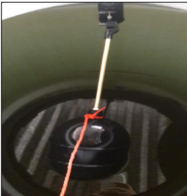
Fotografía N° 05 Inspección del estado del tanque de almacenamiento de agua.
