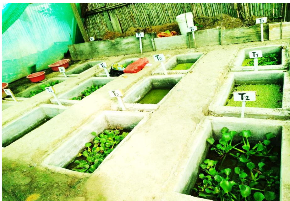
Foto N 13: humedales artificiales con macrófitas
