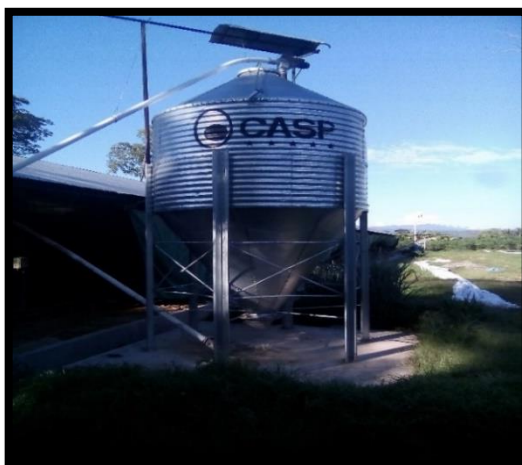
Figura 4: Silos de Almacenamiento de Alimento. Granja Avícola Inversiones JABRINI Import SAC.
