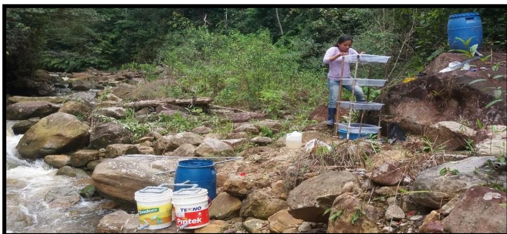
*Fotografía N° 10: Colocación del material filtrante en la batería de filtro.*
