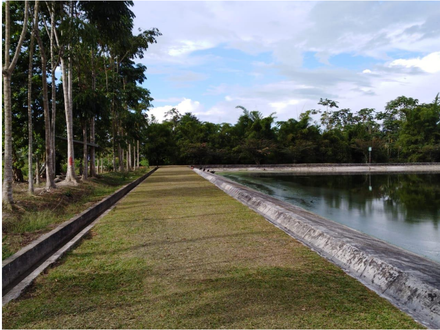
Fotografía 9. Canales que rodea a las lagunas.
