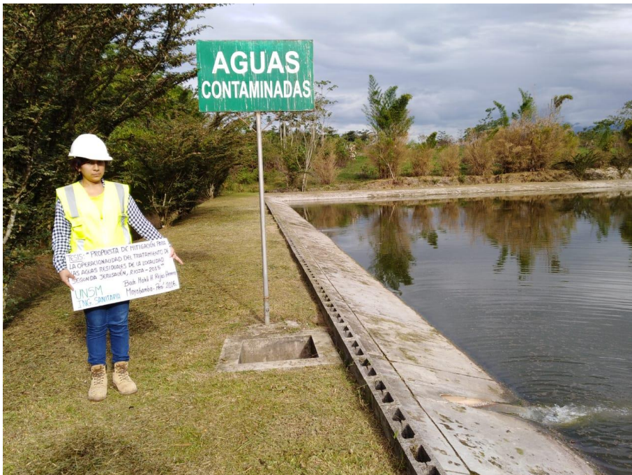
Fotografía 4. Ingreso de las aguas tratadas de la laguna primaria.
