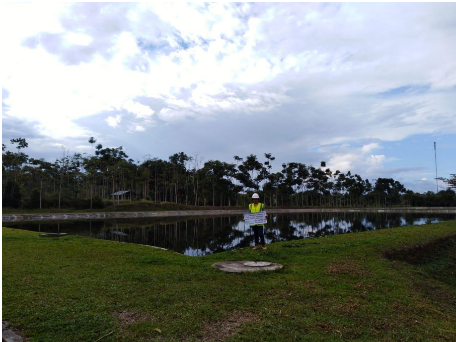
Fotografía 8. Laguna facultativa secundaria.
