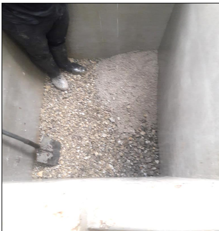
Fotografía 10. Llenado de filtro con la tercera capa de material filtrante.
