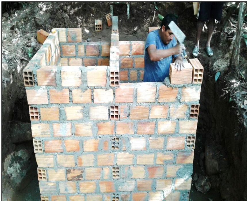
Fotografía 3. Asentado de ladrillos hasta una altura de 2.55 m.
