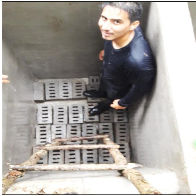
Fotografía 7. Colocación de ladrillos de concreto para el sistema de drenaje.
