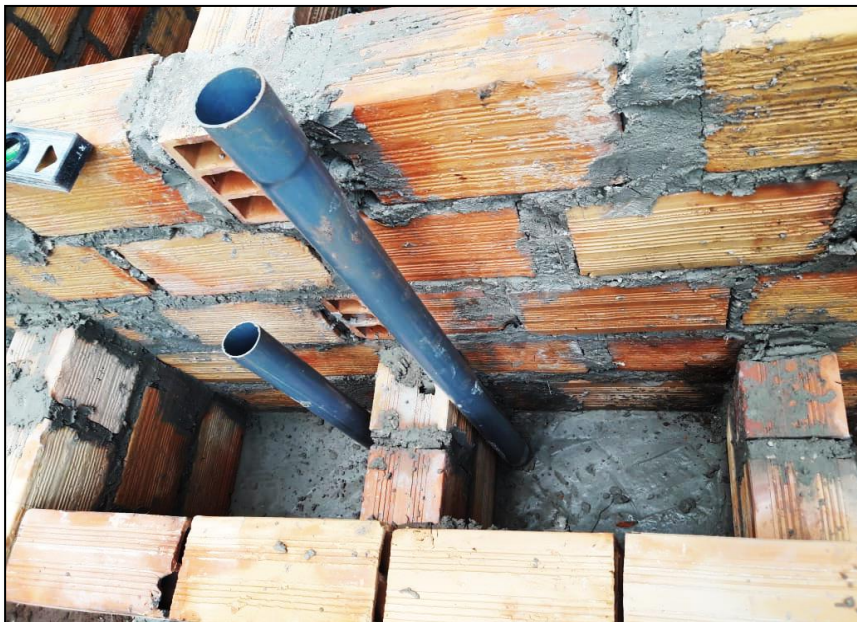
Fotografía 5. Colocación de tubos para salida de agua de cada filtro.
