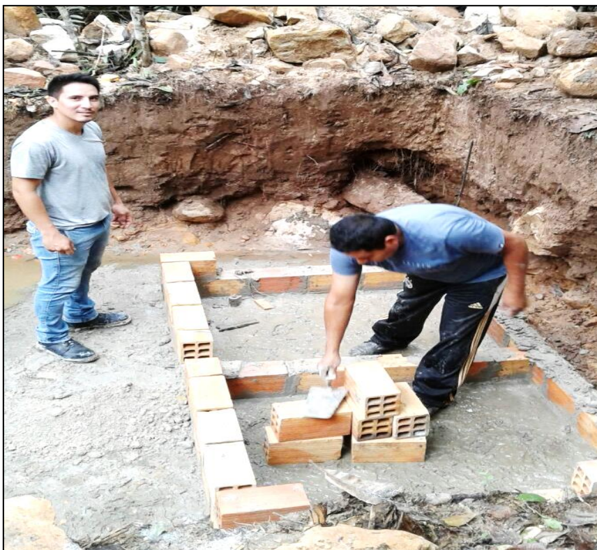
Fotografía 2. Asentado de la primera fila de ladrillos
