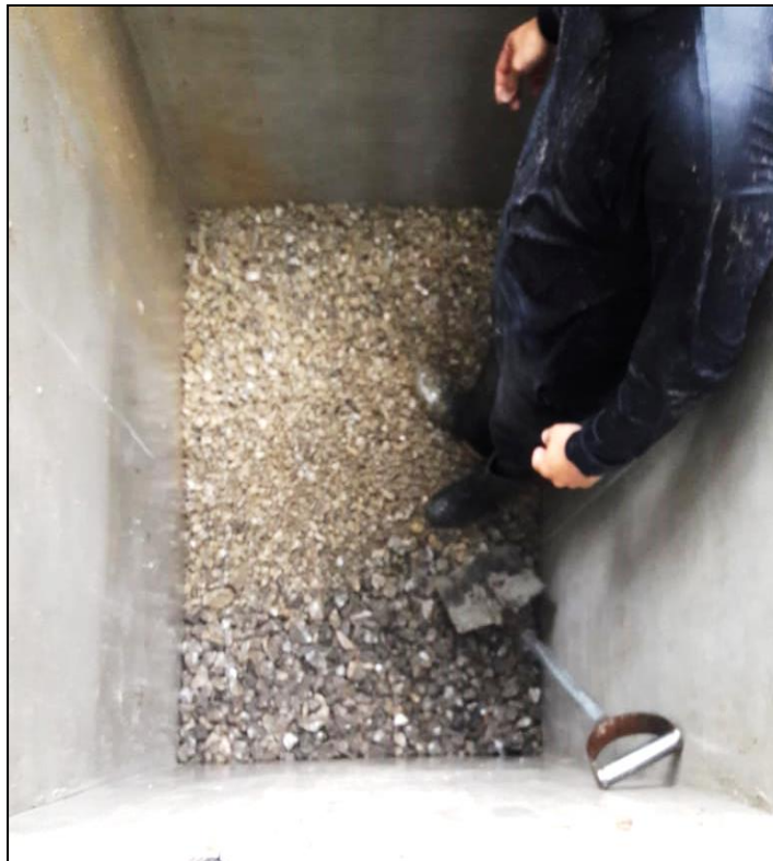
Fotografía 9. Llenado de filtro con la segunda capa de material filtrante.
