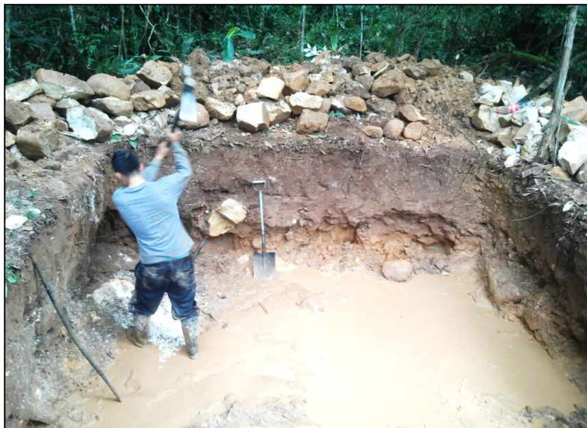
Fotografía 1. Excavación manual del terreno para los filtros.
