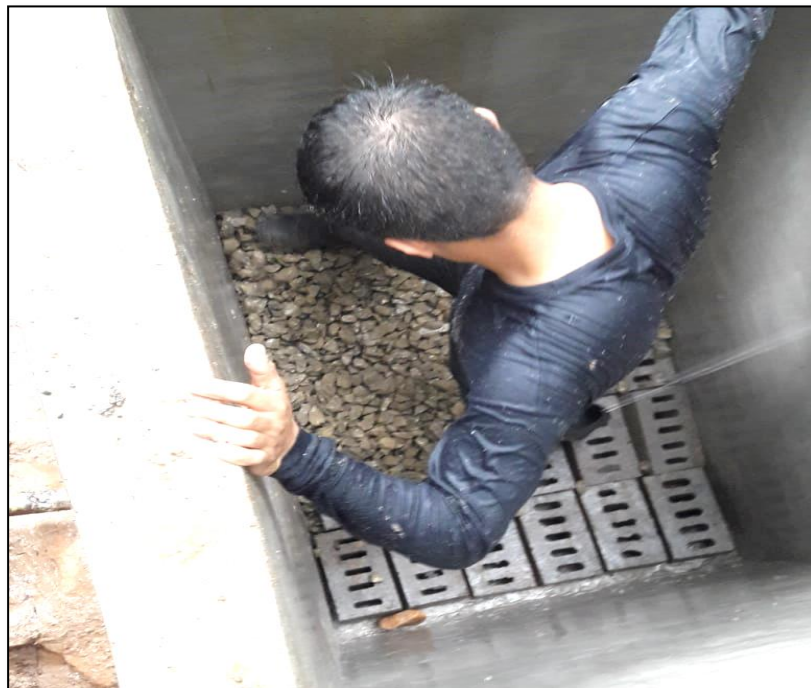
Fotografía 8. Llenado de filtro con la primera capa de material filtrante.
