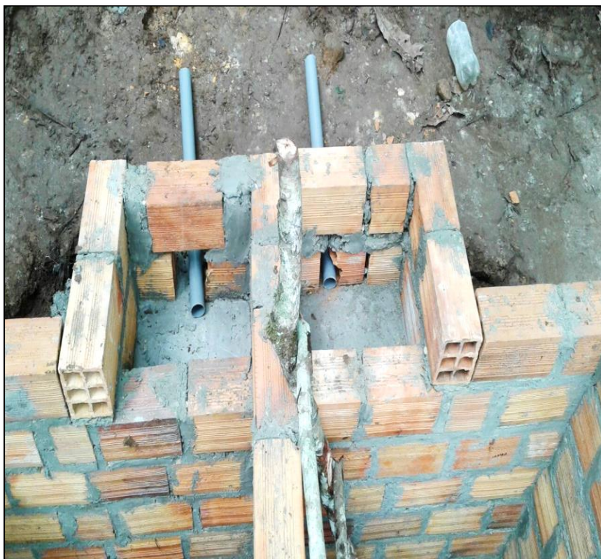
Fotografía 4. Colocación de tubos para el ingreso de agua a cada filtro.
