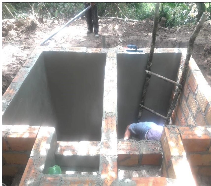
Fotografía 6. Impermeabilización del área interna de los filtros.
