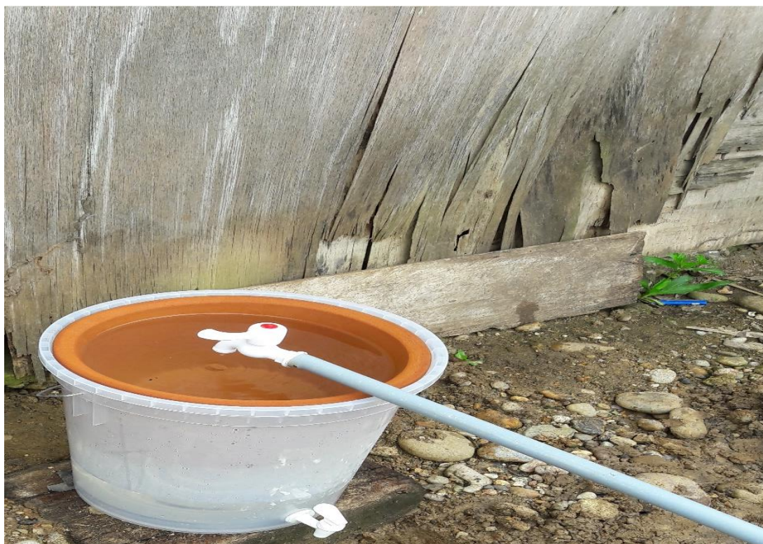
Fotografía 4: Verificación del funcionamiento del filtró
