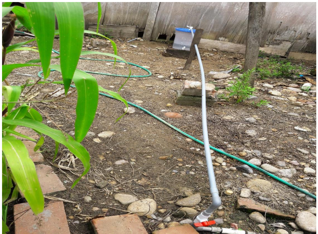
Fotográfica 3: Instalación del filtro domiciliario
