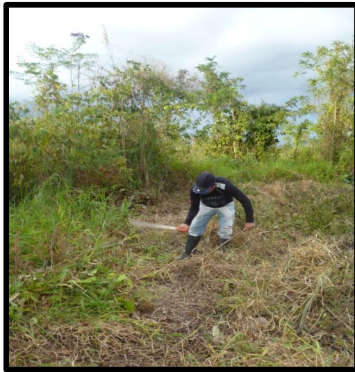
Figura 1: Limpieza del terreno
