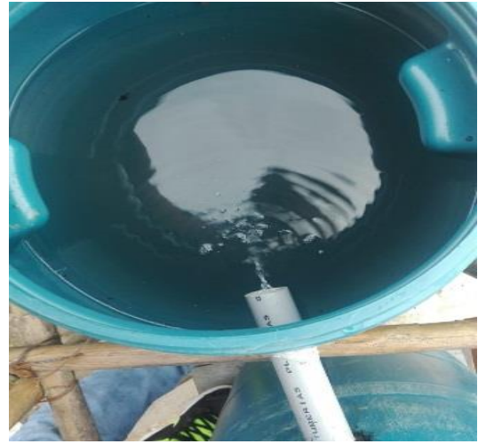
Foto N° 8: Filtro de aguas grises instalado en la vivienda familiar.
