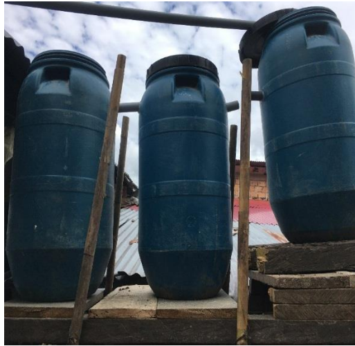
Foto N° 7: Filtro de aguas grises instalado en la vivienda familiar.
