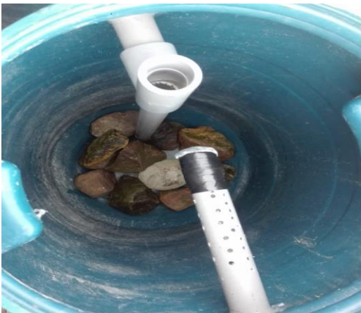
Foto N° 9: Filtro de aguas grises instalado en la vivienda familiar.
