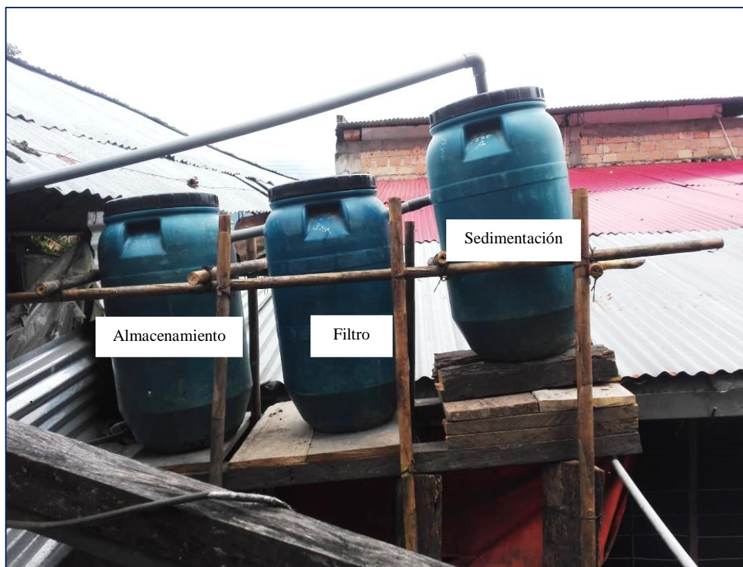
Figura 7. Contenedores y filtro, (ver plano D-01).
