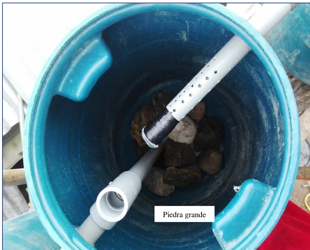
Figura 8. Primera capa del filtro.
