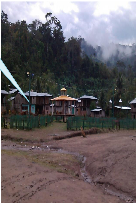
Figura 1: Ubicación de la obra (Fuente: Elaboración Propia)
