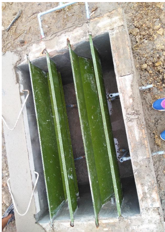
Fotografía 3. Construcción del tanque imhoff –HA.
