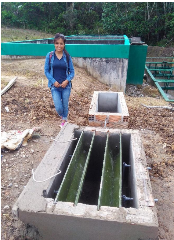
Fotografía 3. Construcción del tanque imhoff –HA.
