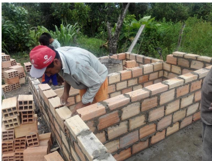
Fotografía 2. Construcción de paredes con ladrillo tipo sogá
