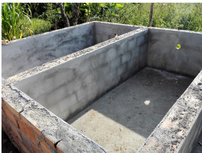
Fotografía 3. Tarrajeo de muros e impermeabilizado con Zika
