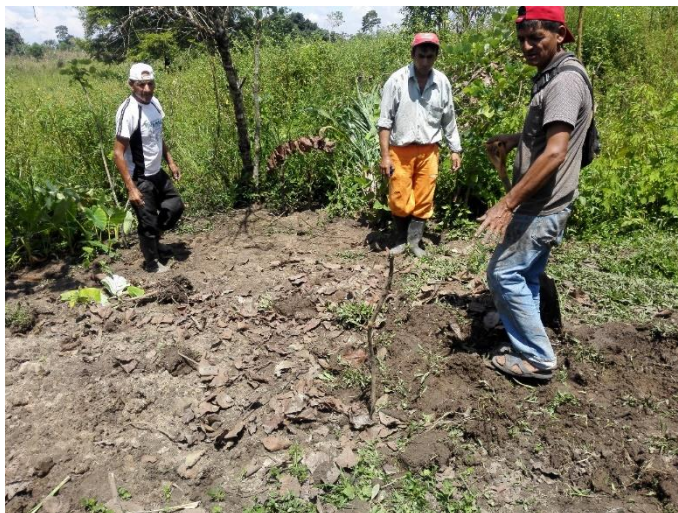
Fotografía 1. Selección y limpieza del terreno
