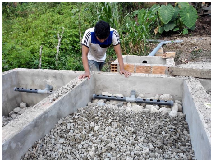
Fotografía 8. Colocación de la grava
