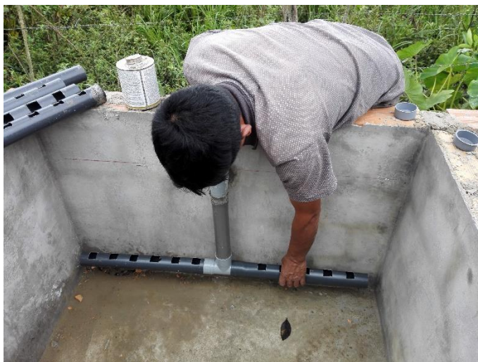
Fotografía 5. Instalación de accesorios sanitarios
