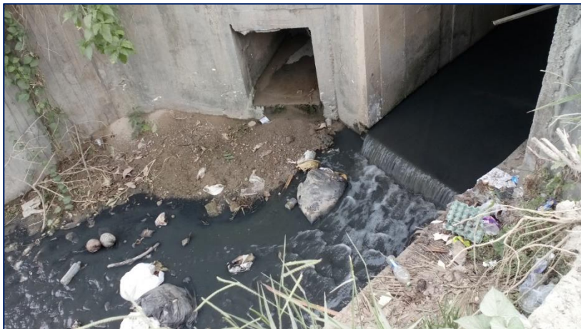
Foto 5: Desagüe bajada de sango – antes quebrada Chahuariyacu
