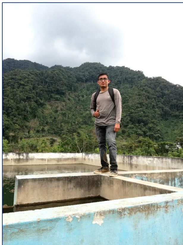
Fotografía 12. Verificación de la planta de tratamiento en mal estado del centro poblado Bajo Naranjillo (Awajun)
