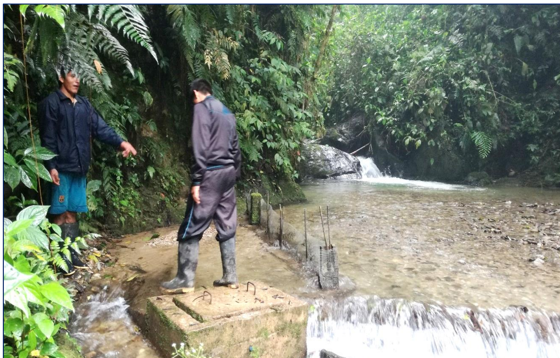
Fotografía 6. Verificación del estado de la captación de agua del centro poblado San Carlos
