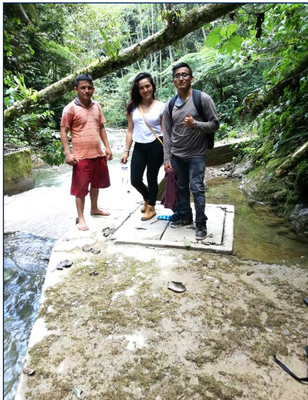
Fotografía 11. Verificación del sistema de agua del centro poblado Bajo Naranjillo (Awajun)
