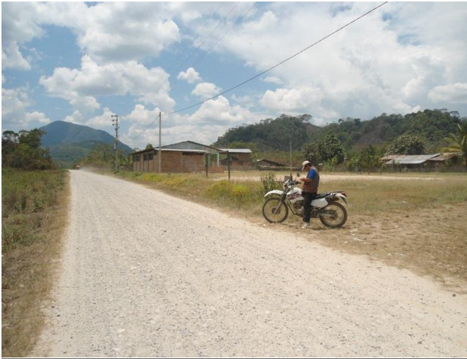
Fotografía N°01: Inicio del Tramo en estudio EMP.SM-638(El Milagro) - Pedro Pascacio Noriega - Campo Alegre - EMP.PE-5N (San José Del Morro), presenta la pérdida de la carpeta de rodadura, (km 00+000).
