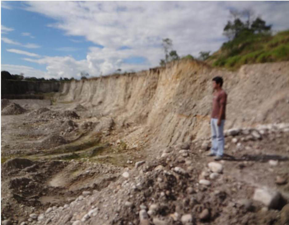
Fotografía N°09: Se comprobó in-situ el color textura y calidad de material, para ser utilizado en la capa de afirmado, corroborando a lo que dice el estudio de mecánica de suelos.
