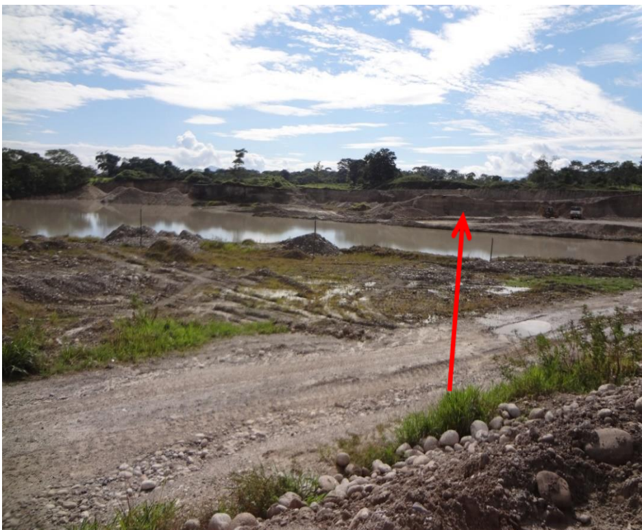
Fotografía N°10: En la Actualidad la Cantera Garate, posee material seleccionado listo para ser utilizado.
