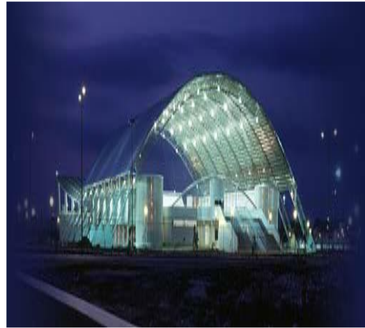
Figura 14: Fachada de gimnasio polifuncional.
