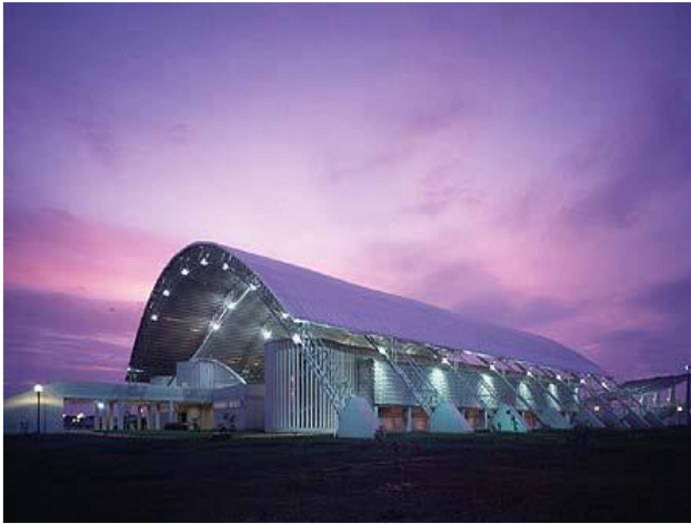
Figura 13: Fachada de gim polifuncional. Unidad deportiva
