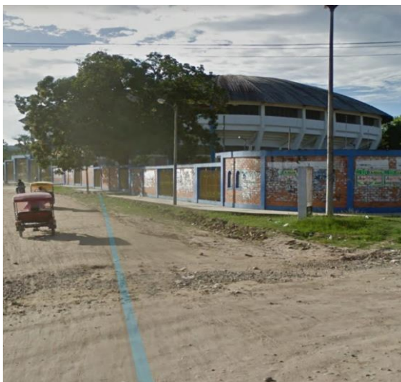
Figura 54: Primera vista lateral del coliseo cerrado
