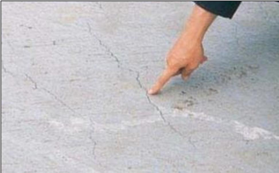
**Figura 5:** Fisuras típicas por retracción plástica (Fuente: Elaboracion Propia)
