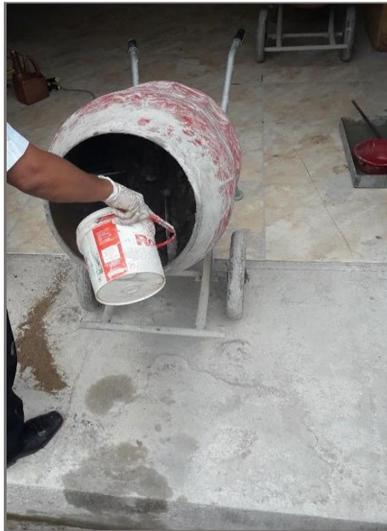
*Fotografía 1: Mezclado del concreto.*
