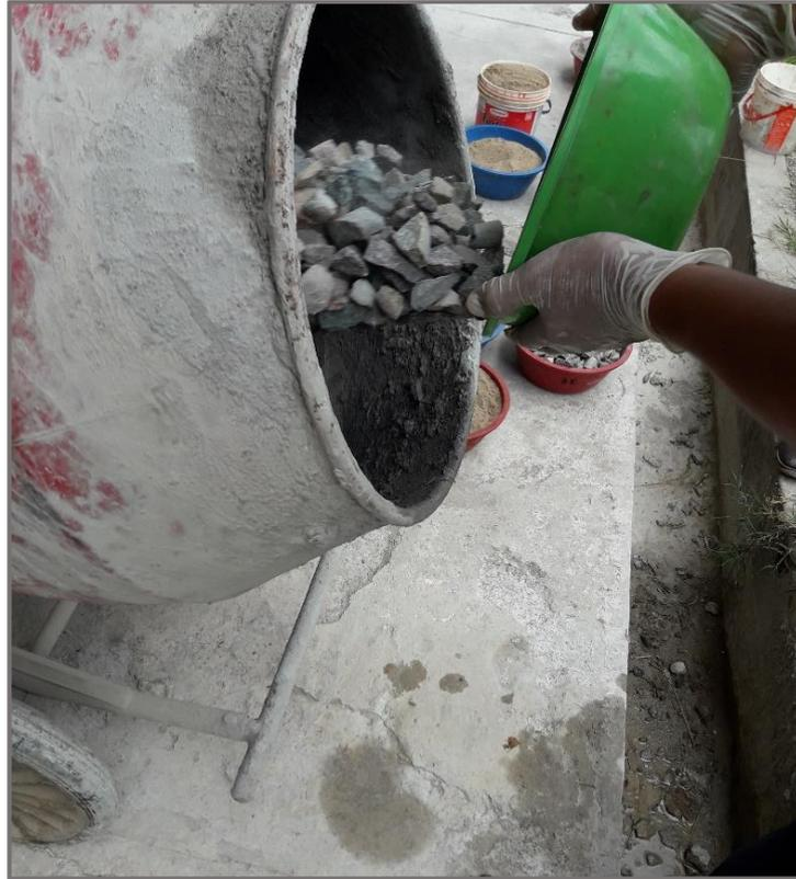
*Fotografía 13: Preparación del concreto.*
