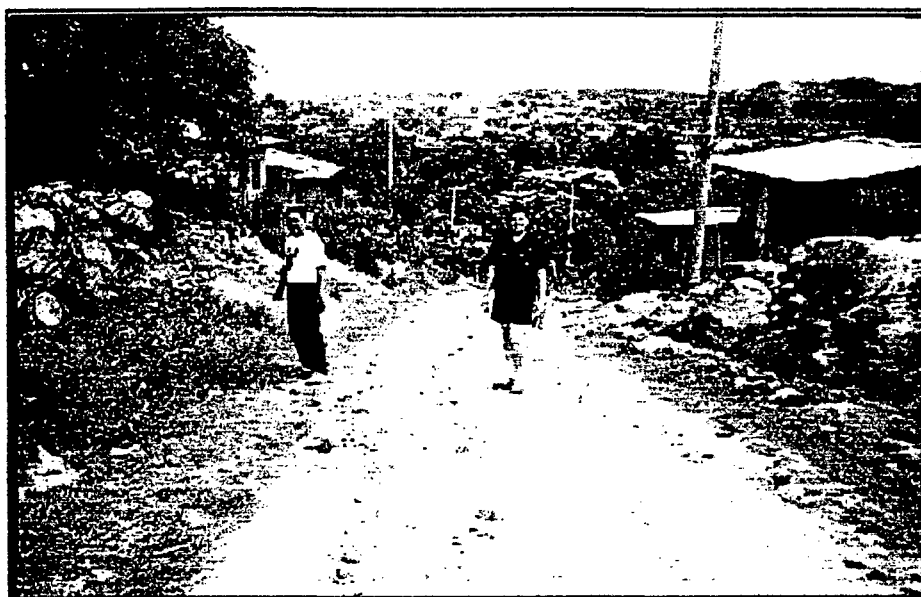
Se aprecia la falta de cunetas en el Jr. Recreo
