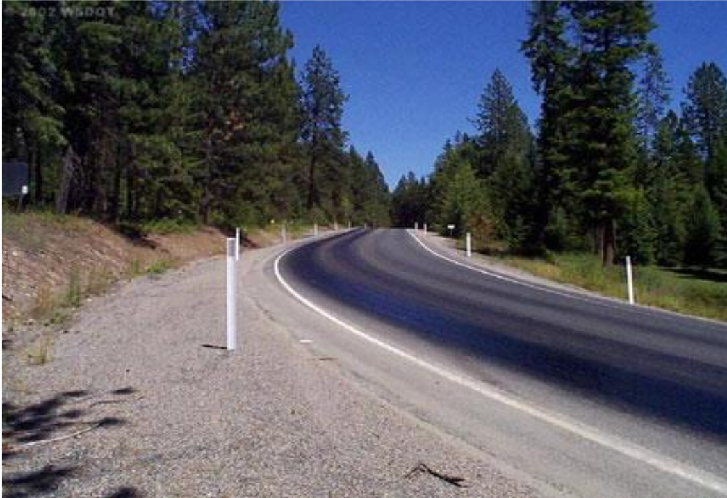
Figura 20. Exudación con nivel de severidad alta (Fuente: Corros, Urbáez y Corredor (2009))
