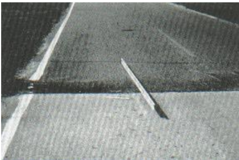
Figura 60. desplazamiento con nivel de severidad alta (Fuente: Vásquez (2002))
