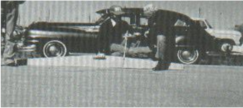
Figura 30. Depresión con nivel de severidad bajo o leve (Fuente: Vásquez (2002))
