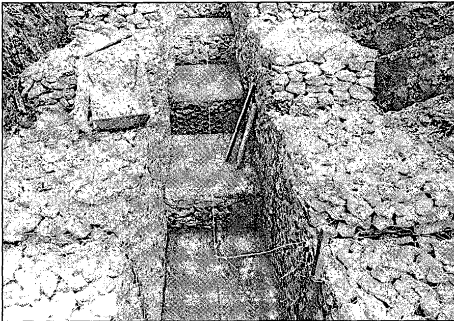
Fig. 2 – 2 – 6 Obra de Canalización
