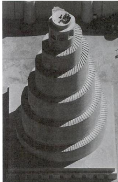
Figura 11: Minarete (siglo IX) de sesenta metros de altura en la Gran Mezquita de Samarra actualmente Irak. Fuente: Gallegos, Héctor y Casabonne, Carlos, Albañilería Estructural (2005).
