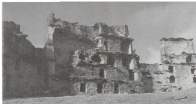
Figura 7: Edificio multifamiliar Yarovilca. Fuente: Gallegos, Héctor y Casabonne, Carlos, Albañilería Estructural (2005).
