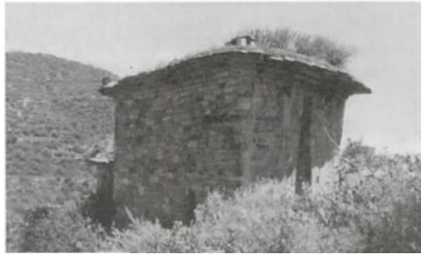
Figura 5: Casa Atavillo de dos niveles con muros de sección variable y ménsulas. Fuente: Gallegos, Héctor y Casabonne, Carlos, Albañilería Estructural (2005).
