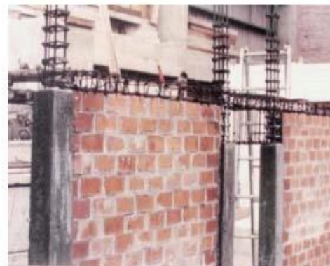
Figura 28: Fuerzas internas producidas en el dintel por sismo y detalle constructivo del dintel entre muros de albañilería (Fuente: del Blog del Ing. San Bartolomé).
