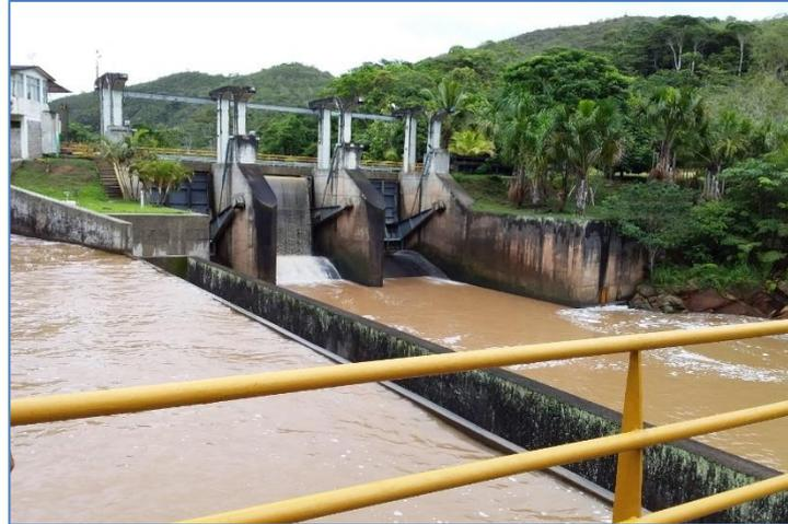
*Ilustración 14:* Barraje Móvil en la Central Hidroeléctrica del Gera- Moyobamba
