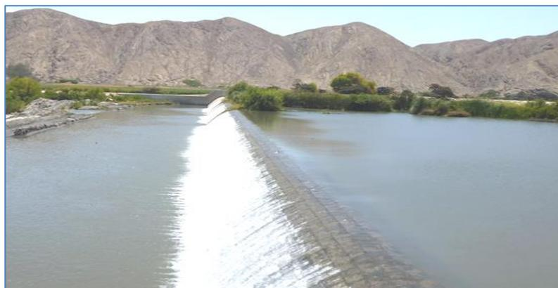
*Ilustración 13:* Bocatoma de barraje fijo del Proyecto Chincas
