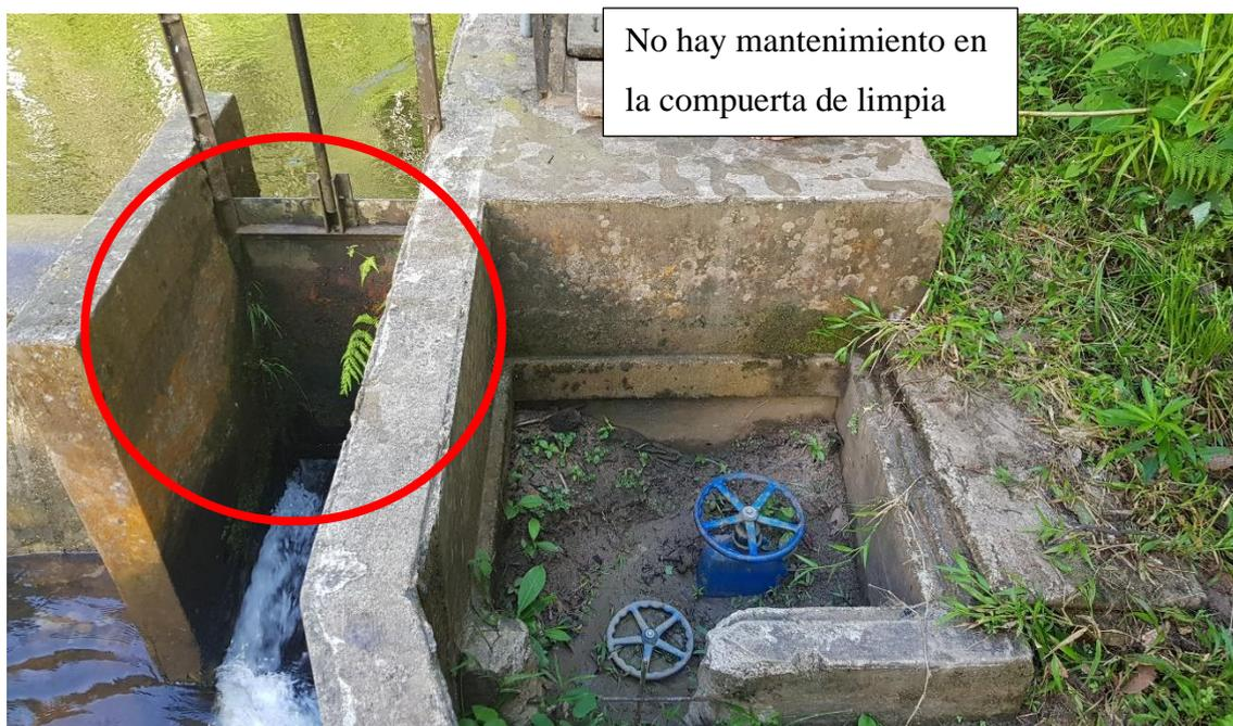
*Ilustración 9: Fotografía de la Captación-Bocatoma (Fuente: Fotografía propia)*
