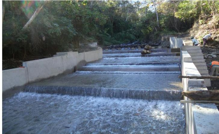
*Ilustración 16:* Bocatoma Tirolesa con colchones de amortiguamiento en parte montañosa
