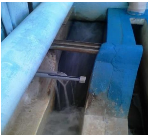
Fotografía 01. Canaleta parshall de la PTAP - Moyobamba
