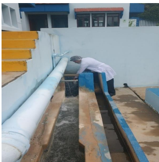
Fotografía 05: Extracción de las muestras de agua cruda, antes del punto de caída del coagulante en la garganta de la canaleta parshall.
