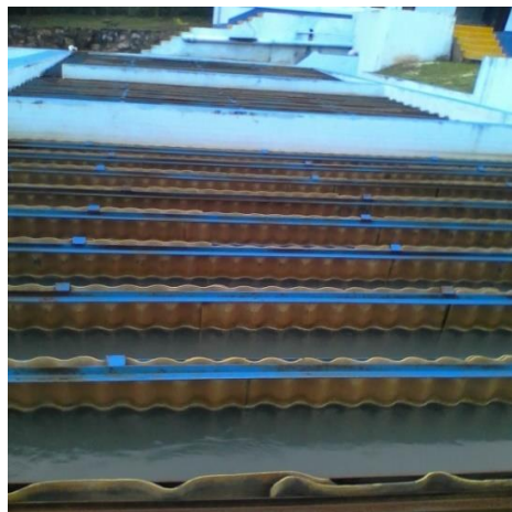
Fotografía 02. Flocladores con pantallas
