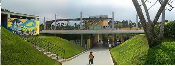
Rampa de ingreso al CREA Huiracocha del distrito de Villa El Salvador
