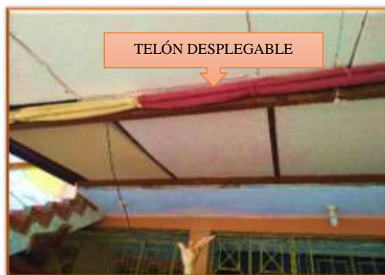
Imagen 4: Cobertura del Ambiente Multiuso del Centro Cultural Rezipistencia (Fuente: Elaboración Propia).
