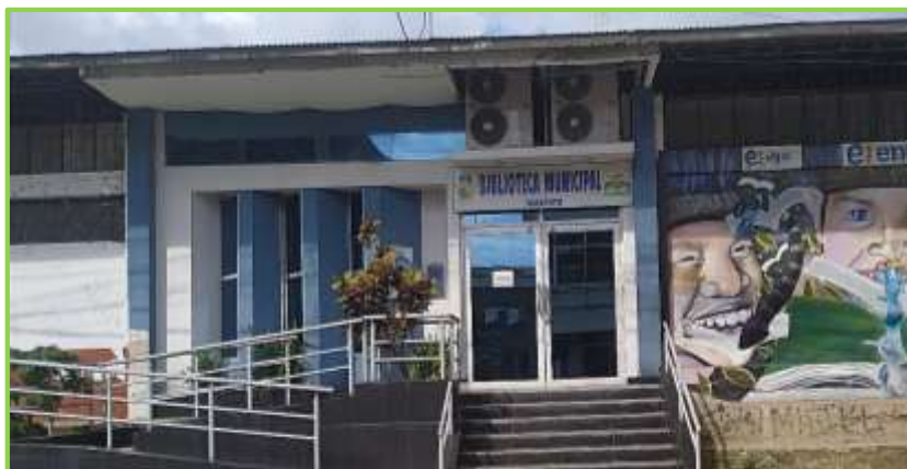
Imagen 37: Fachada Principal de la Biblioteca Municipal
