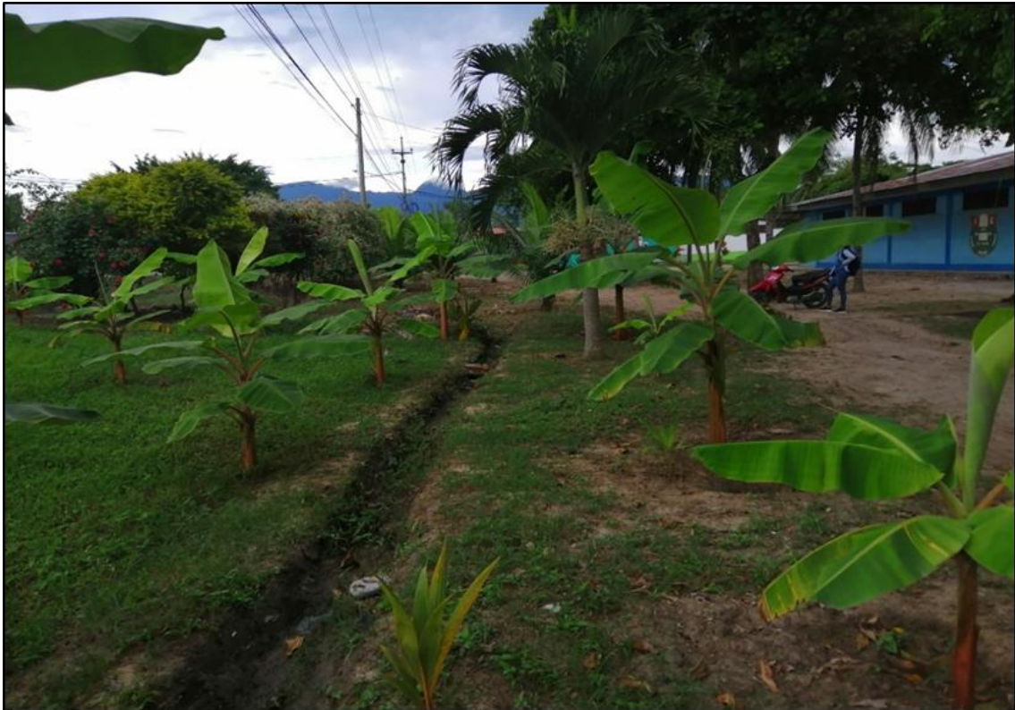
Ilustración 21: Se observa una cuneta natural ubicado en la Av. Las Palmas, frente al colegio, debido a la falta de estructuras de drenaje.
