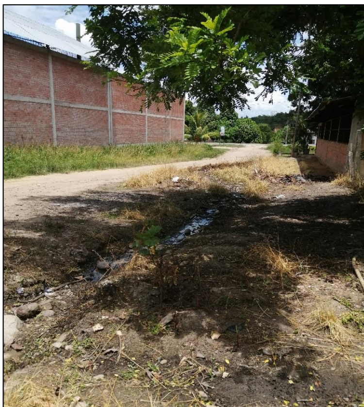
Ilustración 26: Se observa el escurrimiento de agua de lluvia por el Jr. Manuel Vásquez, generando focos de contaminación.
