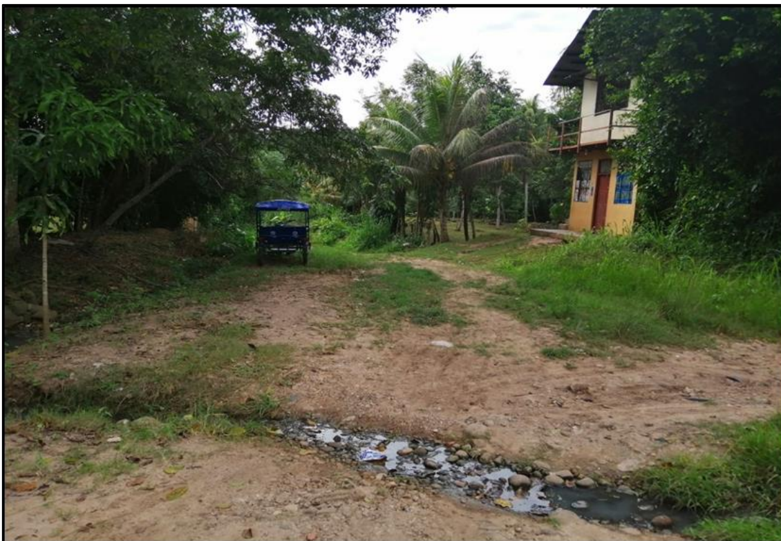
Ilustración 19: Se observa el escurrimiento de agua de lluvia por el Jr. Las Palmeras, generando focos de infección para la población.
