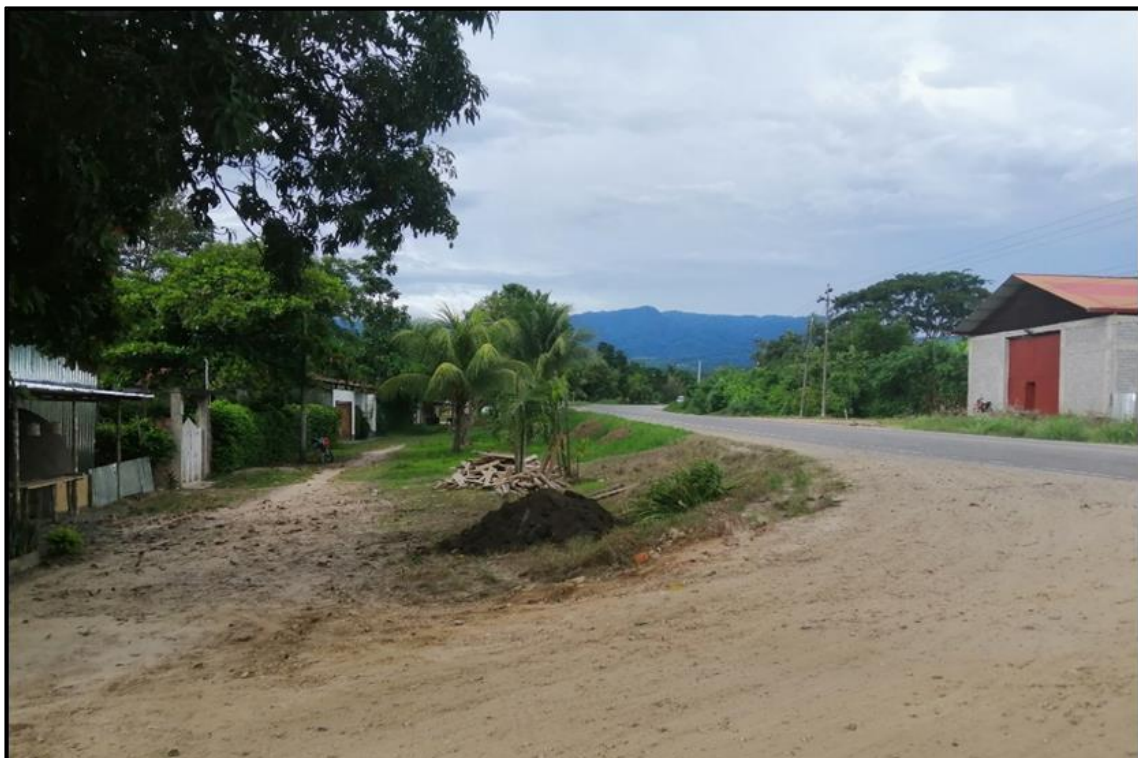
Ilustración 22: Se observa el desnivel del terreno en la Av. Las Palmas, lo que ocasiona que en épocas de lluvias se acumule el agua y perjudique las estructuras de las viviendas aledañas.
