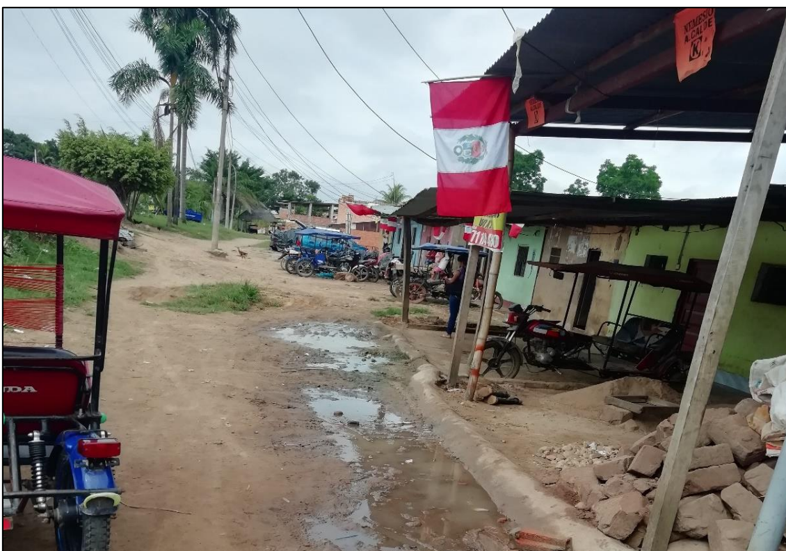
Ilustración 28: Se observa la acumulación de aguas de lluvia en Jr. Manuela Flores, generando un foco de contaminación para la población.
