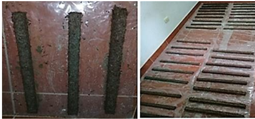
Figura 22. Proceso de curado y fraguado (Fuente: 2018).
