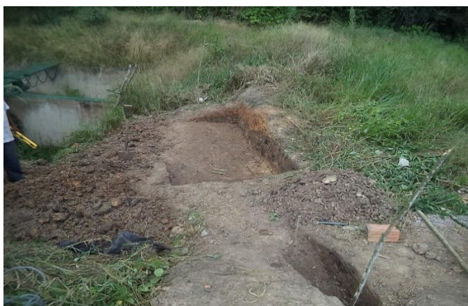
Fotografía 2. Nivelación de terreno
