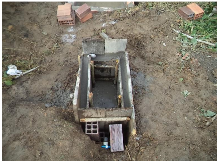
Fotografía 4. Construcción de la caja de registro
