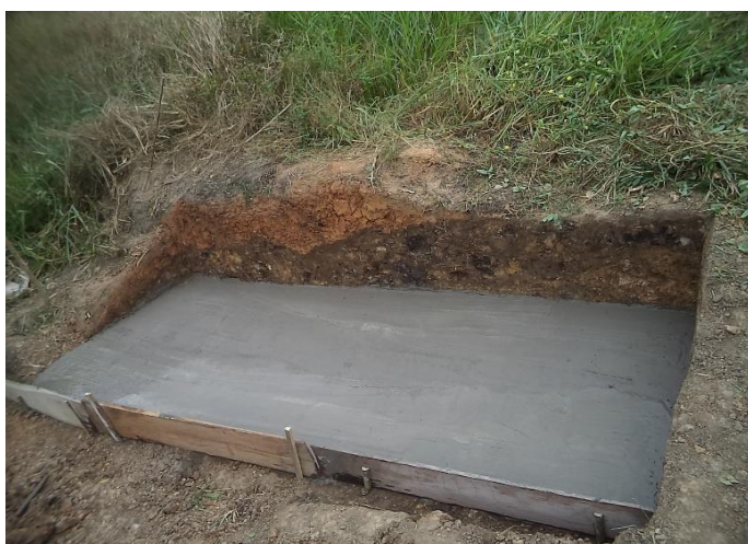
Fotografía 3. Solado de 10 cm
