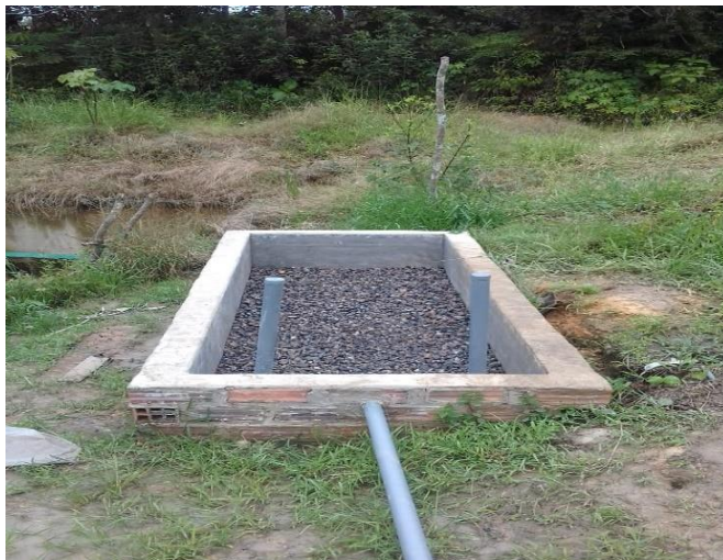
Fotografía 7. Colocación de la grava fina.
