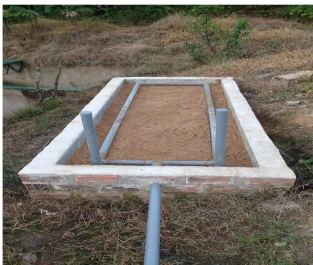
Fotografía 8. Colocación de arena gruesa.
