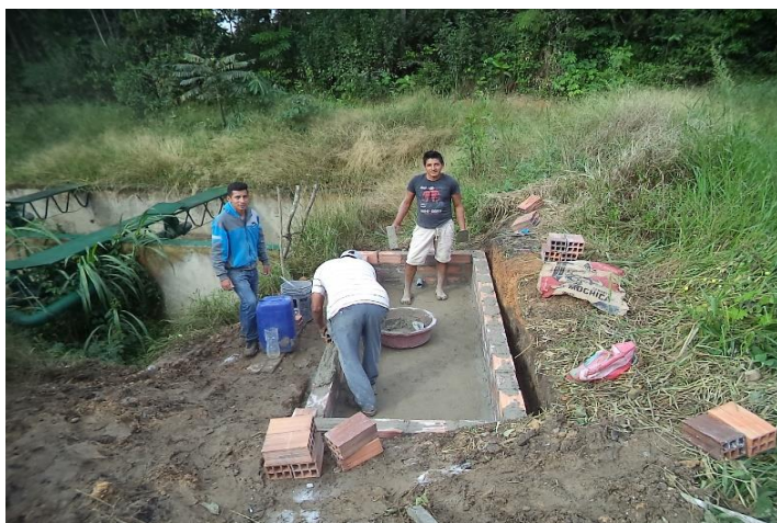
Fotografía 5. Construcción del humedal artificial
