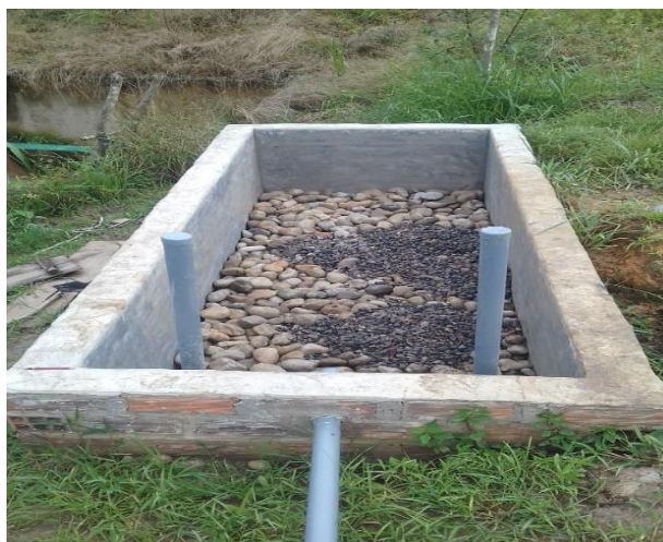
Fotografía 6. Colocación de la grava gruesa
