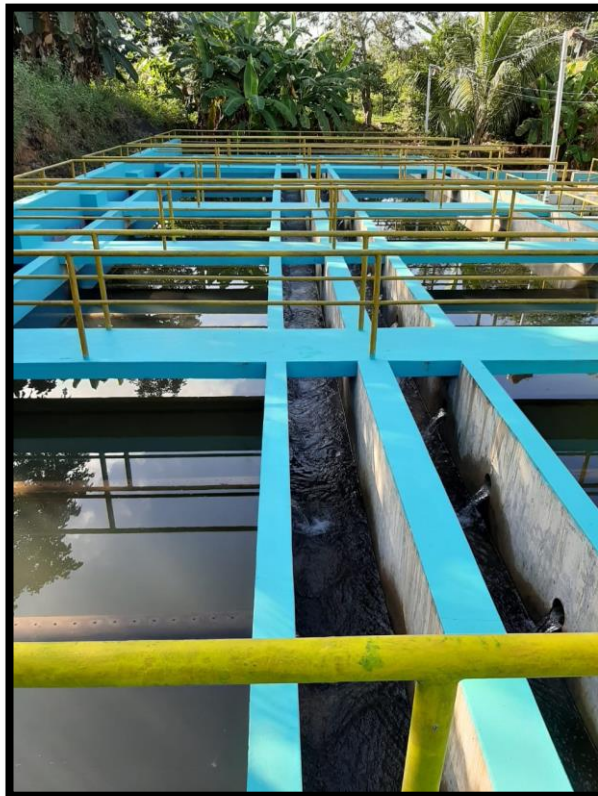
Fotografía 8. Planta de tratamiento Shilcayo
