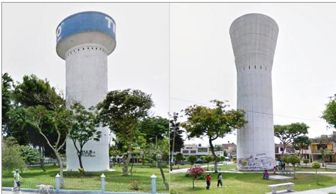
Figura 24: Izquierda Reservorio elevado tipo cilíndrica, derecha Reservorio elevado tipo cónico. (Fuente: Quezada Vera & Salinas Palacios, 2014).
