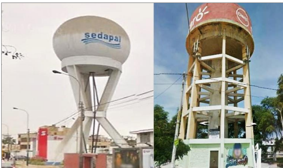
Figura 25: Izquierda Reservorio elevado aporcado tipo esférico, derecha aporcado tipo cilíndrico. (Fuente: Vértiz, 2018).
