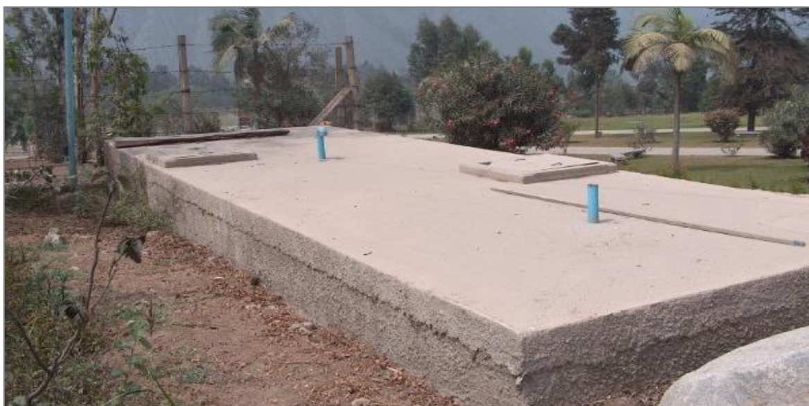
Figura 22: Reservorio semienterrado. (Fuente: UNI, 2005).
