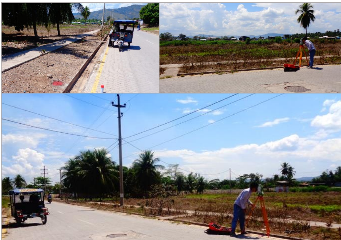
Fotografía 10: Levantamiento topográfico de la zona del proyecto y proyección de los BM auxiliares.
