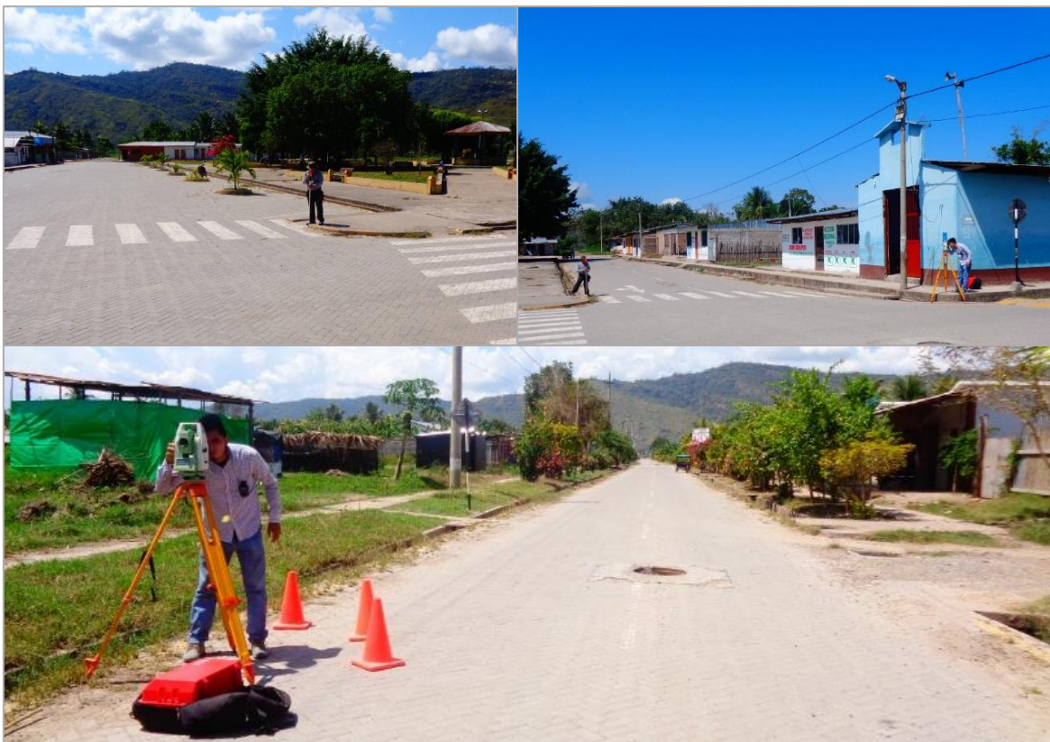
Fotografía 9: Levantamiento topográfico desde BM fijos a la zona del proyecto.
