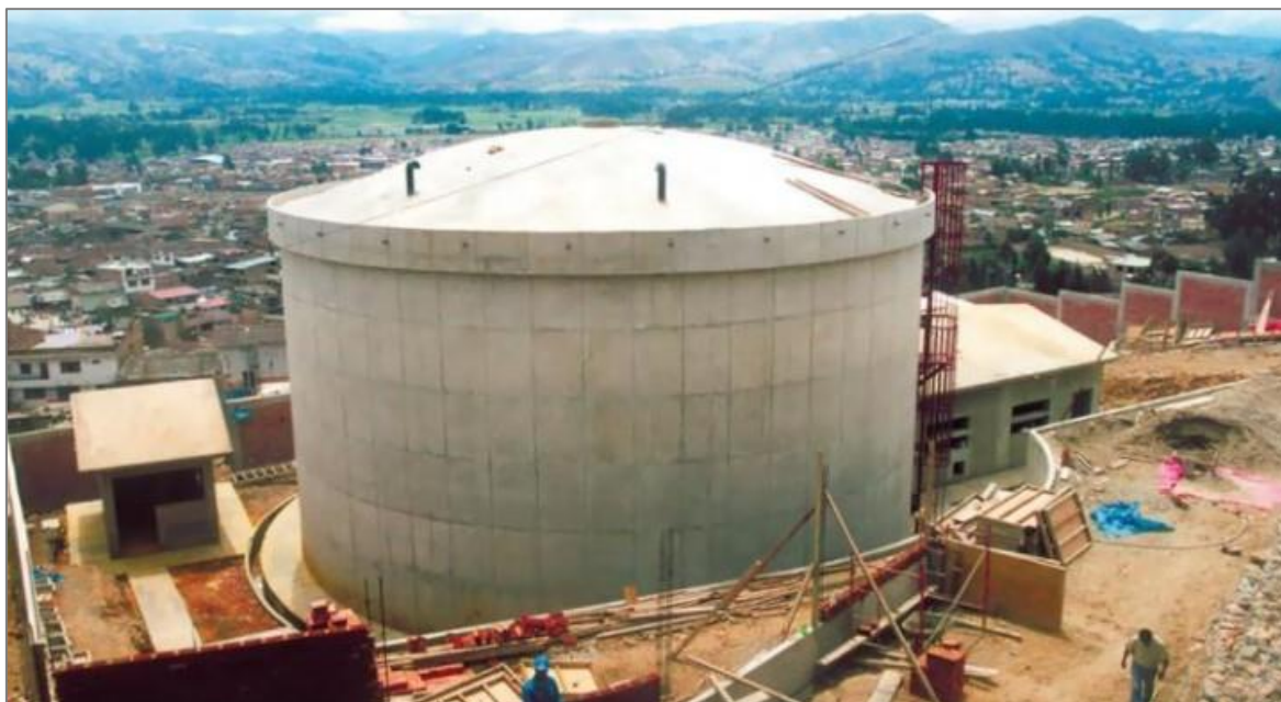
Figura 23: Reservorio apoyado. (Fuente: Carhuapoma & Chahuayo, 2019).
