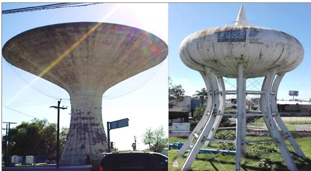
Figura 26: Izquierda Reservorio elevado tipo copa, derecha Reservorio elevado metálico tipo ovalado. (Fuente: Vértiz, 2018).
