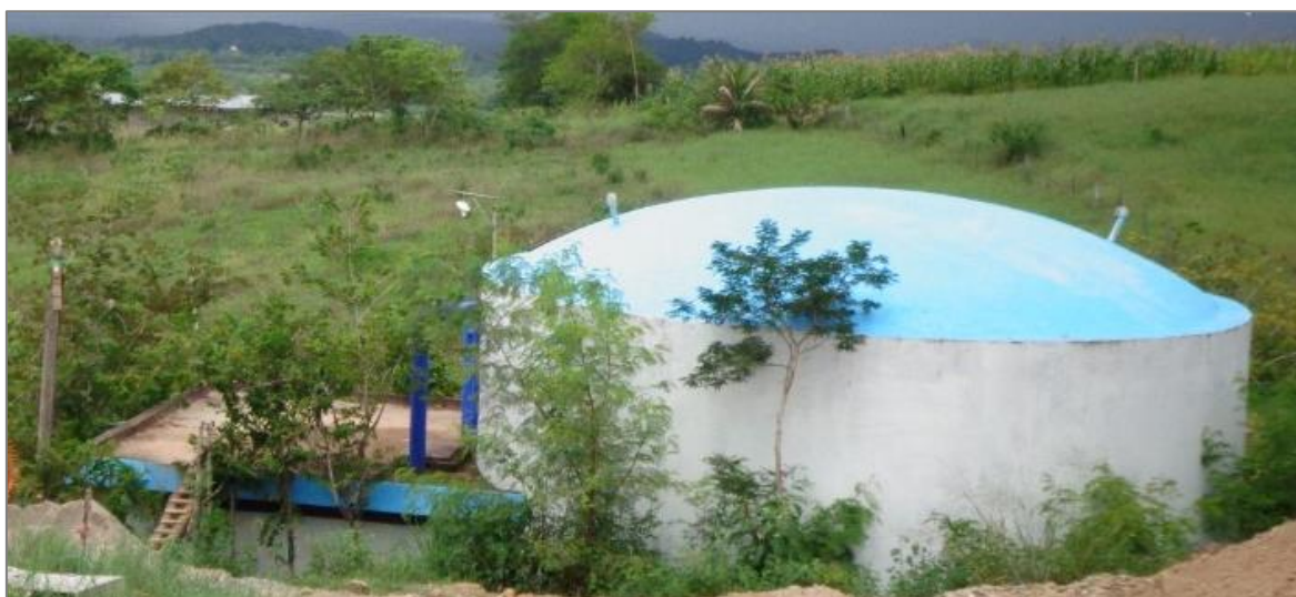
Figura 56: Reservorio existente ramal sur de 250 m 3 en la provincia de Picota. (Fuente: Elaboración propia).
