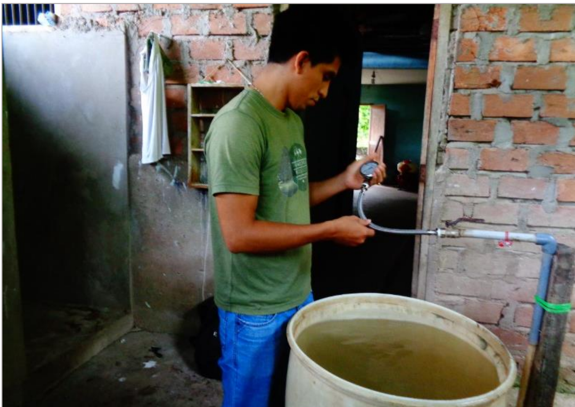
Fotografía 5: Medición de la presión y cálculo del caudal en primera conexión domiciliaria.
