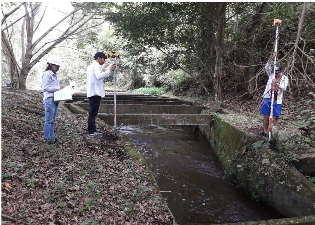
Observación directa y anotaciones sobre el estado situacional actual del canal principal de la irrigación Cumbaza km 00+00 – km 07+620
