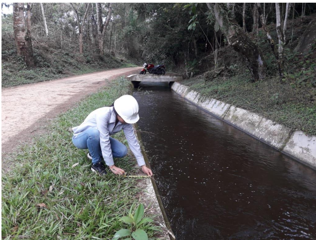
Medición con wincha del revestimiento del canal principal de la irrigación Cumbaza km 00+00 – km 07+620 para su posterior dibujo en Cad
