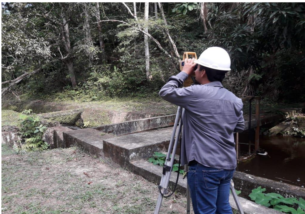
Manejo de la estación total para el levantamiento topográfico del canal principal de la irrigación Cumbaza km 00+00 – km 07+620
