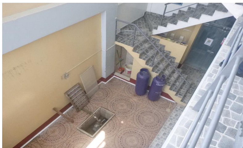
Figura 10. Área de ingreso de vehículos menores y tanque cisterna.
