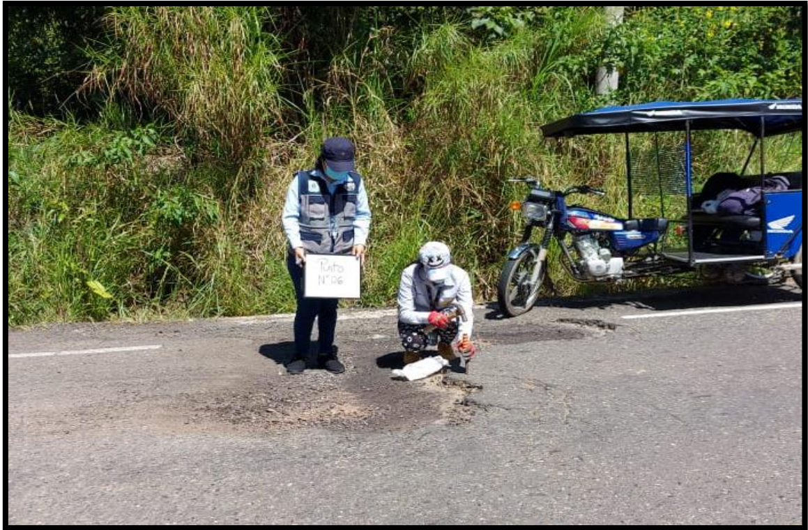
Figura 15: Extracción de muestras de pavimento para ensayos en laboratorio km 06+393. (Fuente Propia)
