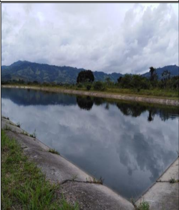
Foto 3: Ingreso a laguna 1
