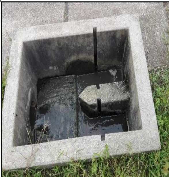
Foto 1: Ingreso primer tratamiento
