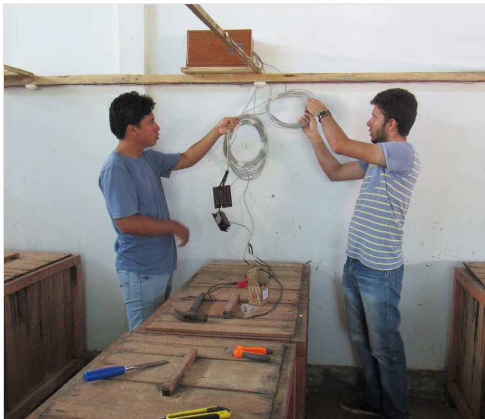
Ilustración 1. Ensamblaje de la red que conecta los sensores con el arduino y raspberry pi
