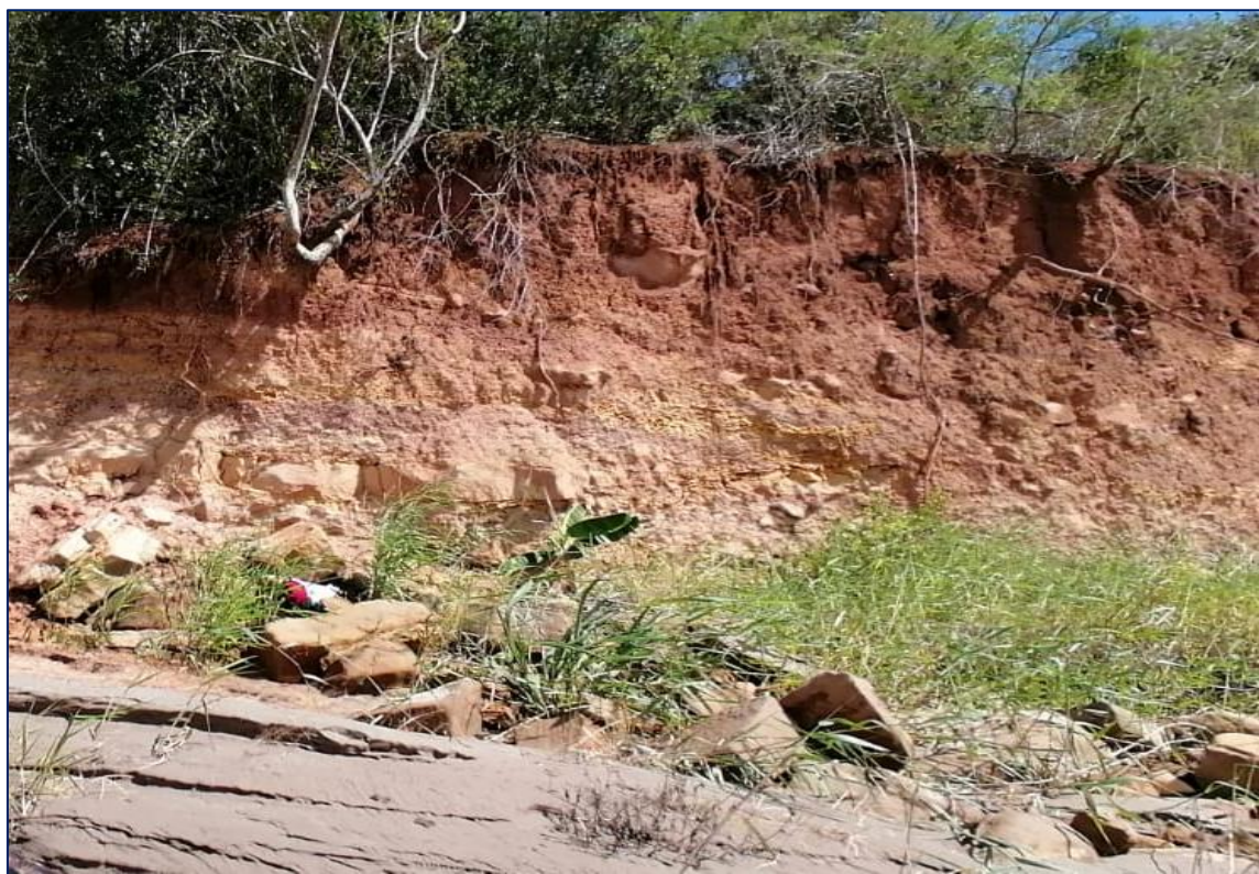
Figura 1. Verificación de la erosión en la margen izquierda. Autor: Diana Arell Abanto Díaz
