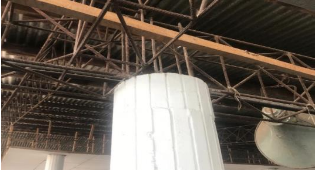
Figura 65. Columnas sin arriostre, elaboración propia.
