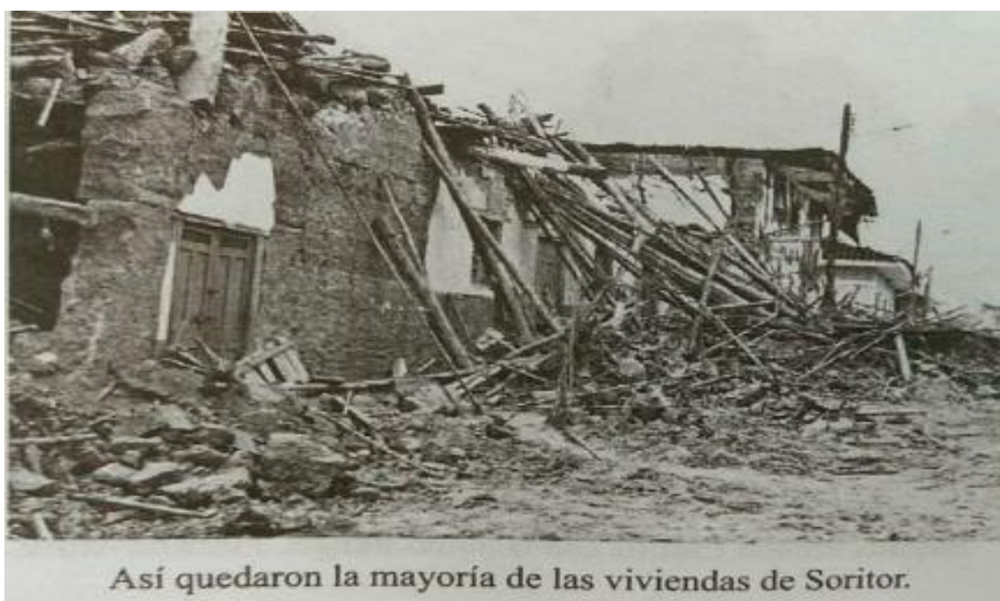
Figura 1. Viviendas colapsadas después del terremoto parte 01
