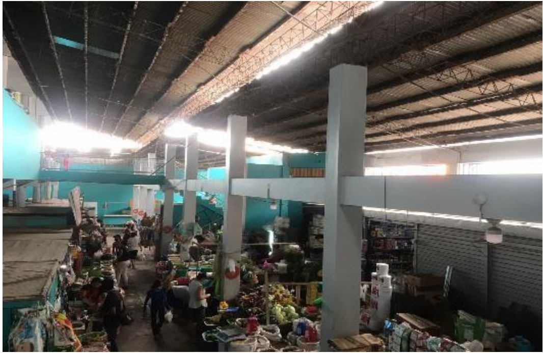
Foto 7: Vista completa de la situación estructural actual de la estructura.
