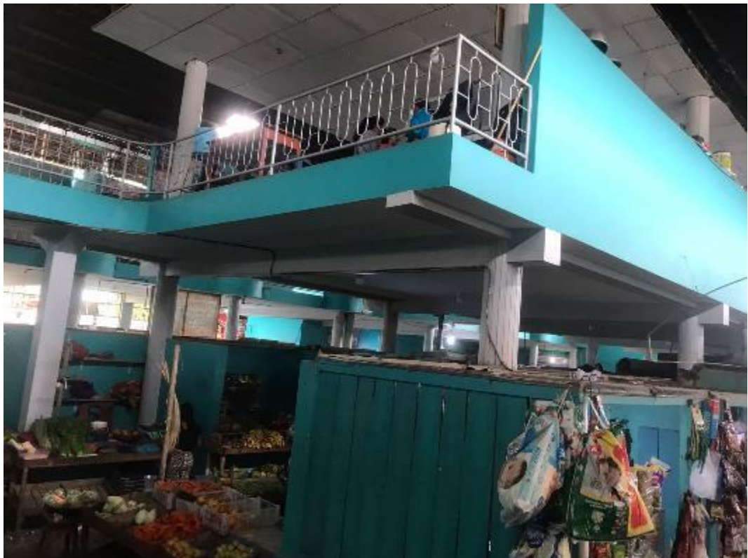
Foto 8: Vista completa de la situación estructural actual de la estructura.
