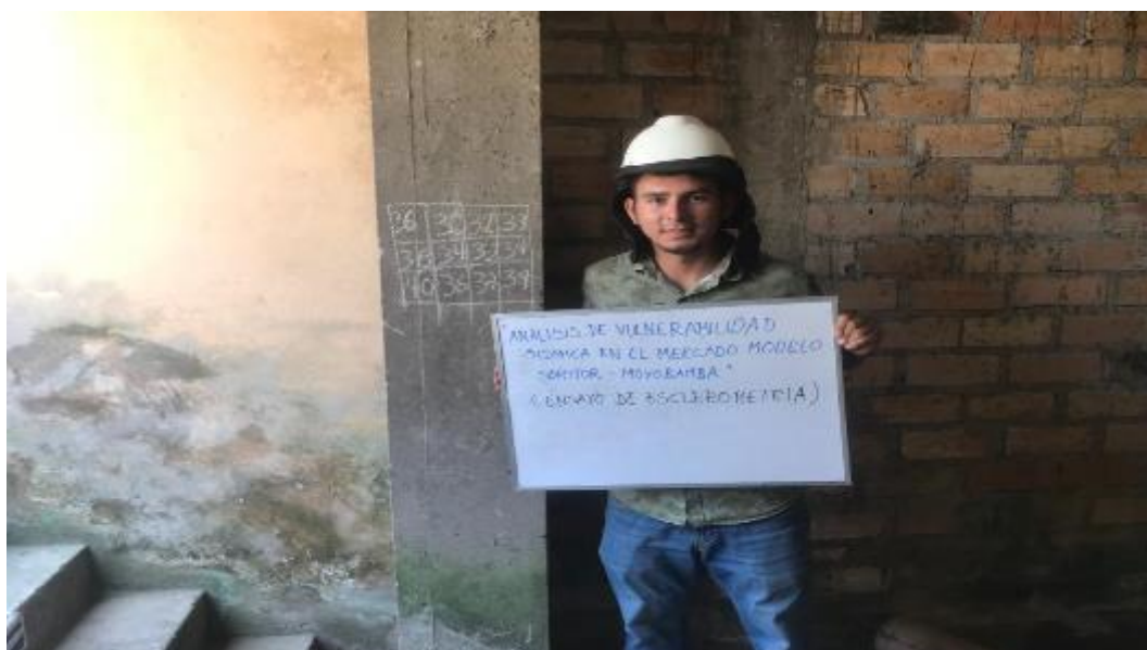
Foto 1: Punto N° 01 para el ensayo de esclerometría en las columnas del tanque de agua del Mercado Modelo Soritor.
