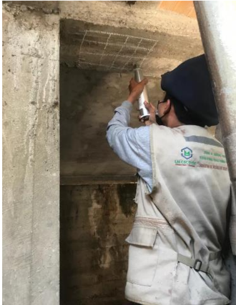
Foto 3: Punto N° 02 Uso del esclerómetro en la viga del tanque de agua del Mercado Modelo Soritor.
