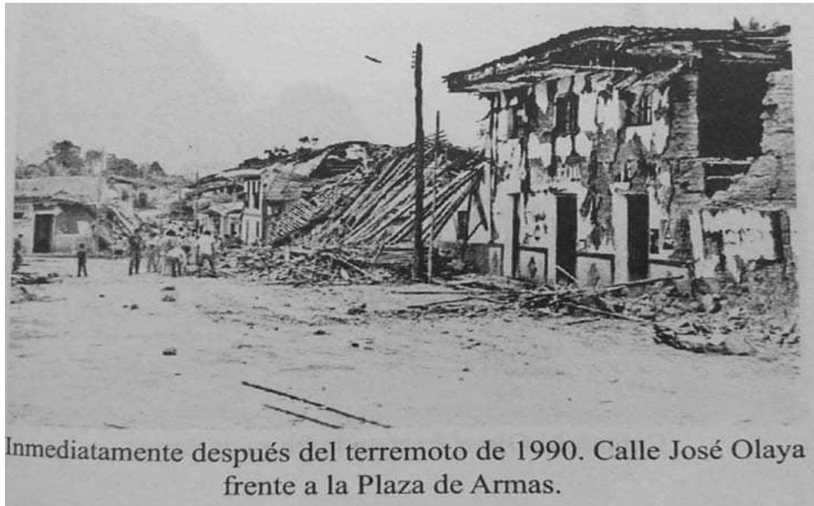
Figura 2. Viviendas colapsadas después del terremoto parte 02
