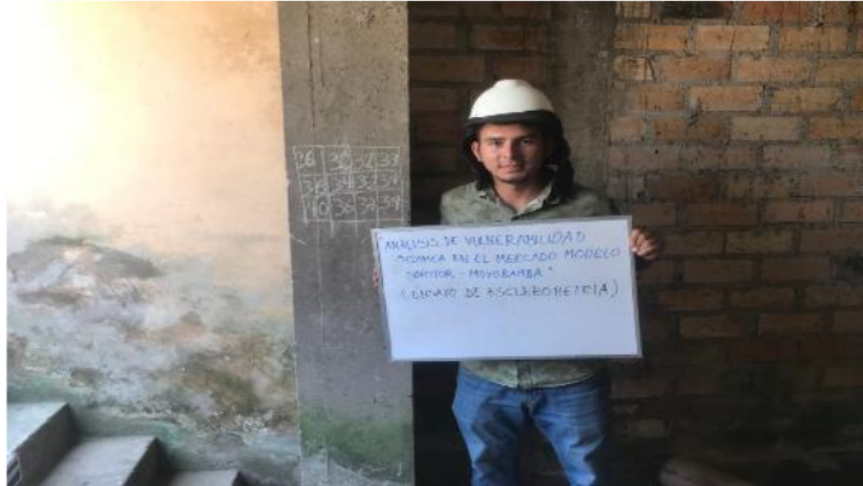
Foto 1: Punto N° 01 para el ensayo de esclerometría en las columnas del tanque de agua del Mercado Modelo Soritor.
