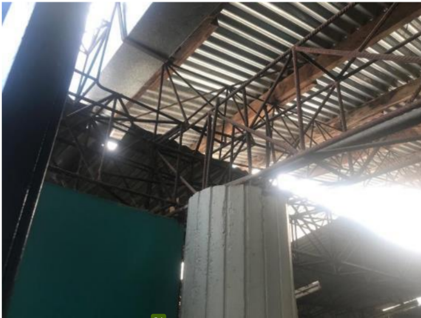
Foto 6: Detalle de la unión entre las columnas de Concreto armado y los tijerales longitudinales de acero estructural f_y = 4200 \text{ kg/cm}^2
