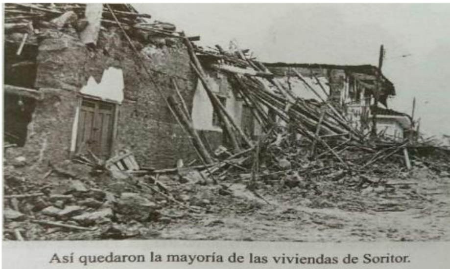
Figura 1. Viviendas colapsadas después del terremoto parte 01
