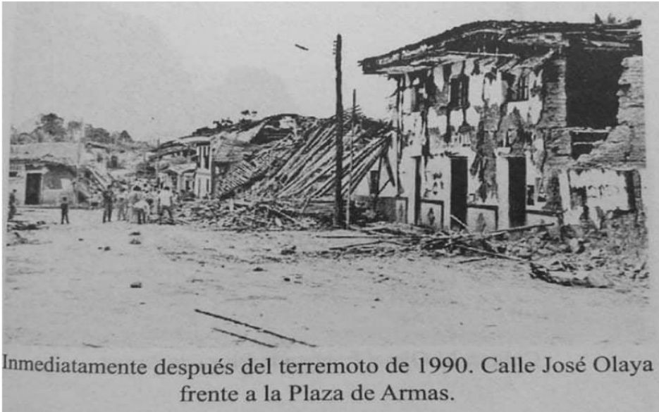
Figura 2. Viviendas colapsadas después del terremoto parte 02
