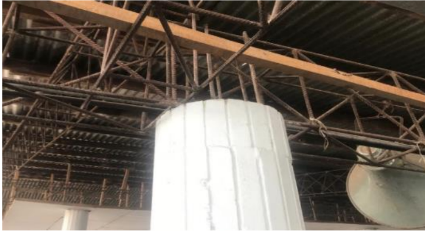
Figura 65. Columnas sin arriostre, elaboración propia.
