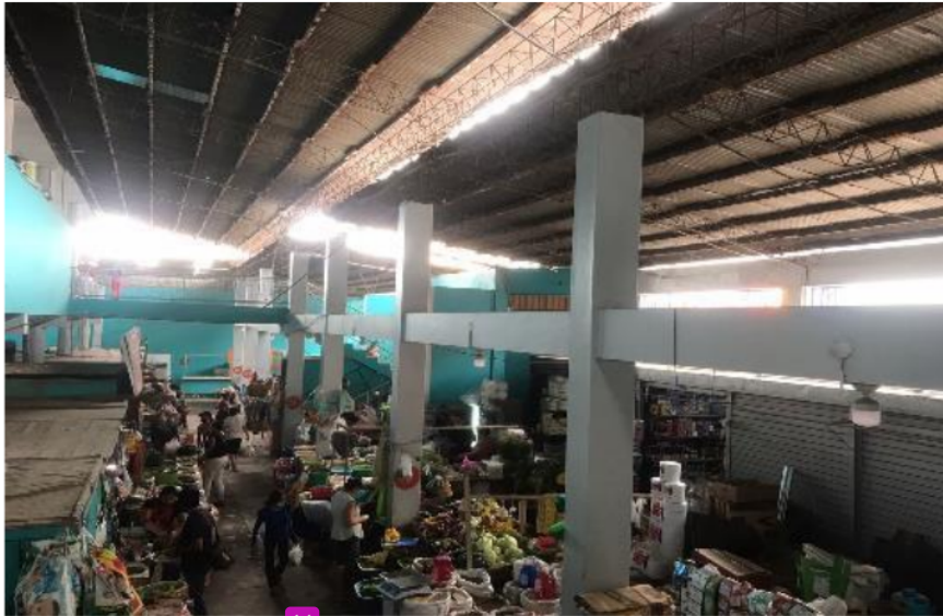
Foto 7: Vista completa de 14 la situación estructural actual de la estructura.
