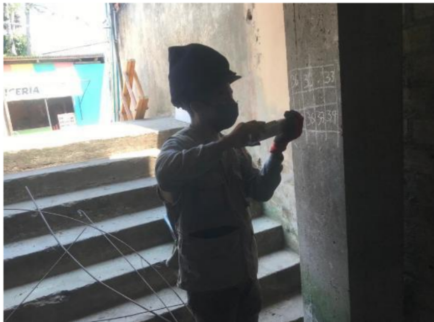
Foto 2: Punto N° 01 Uso del esclerómetro en las columnas del tanque de agua del Mercado Modelo Soritor.
