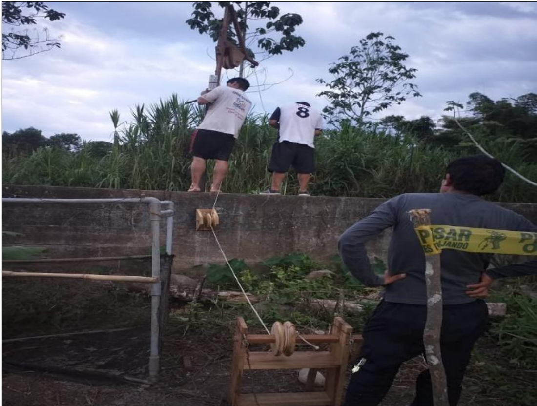
Fotografía 5: Instalación de un sistema de poleas para levantar la caja receptora de residuos.
