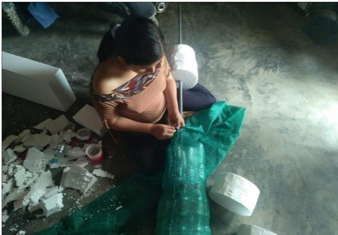
Fotografía 2: Colocación de botellas y malla tipo rashell
