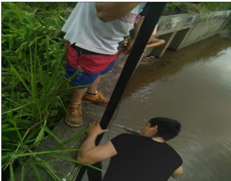
Fotografía 3: Instalación de rieles para el tirante principal.
