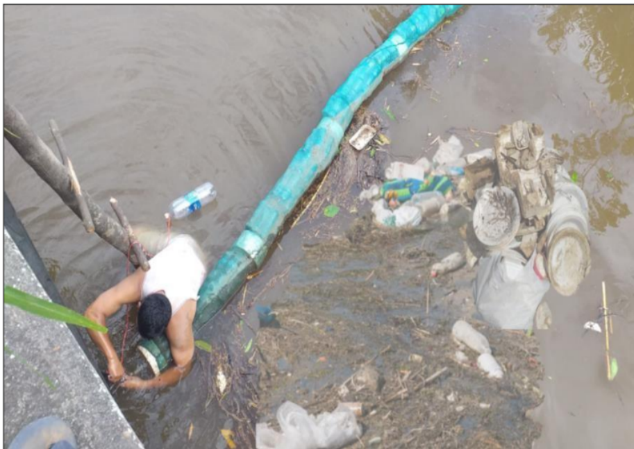
Fotografía 8: Recolección de residuos y ajustes de los templadores
