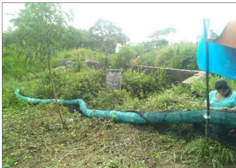
Fotografía 4: Armado de partes de flotar y colocación de la cortina o falda sumergible.
