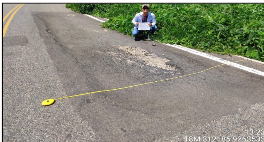
Figura 19. Reparaciones o Parchado – km 7+015
