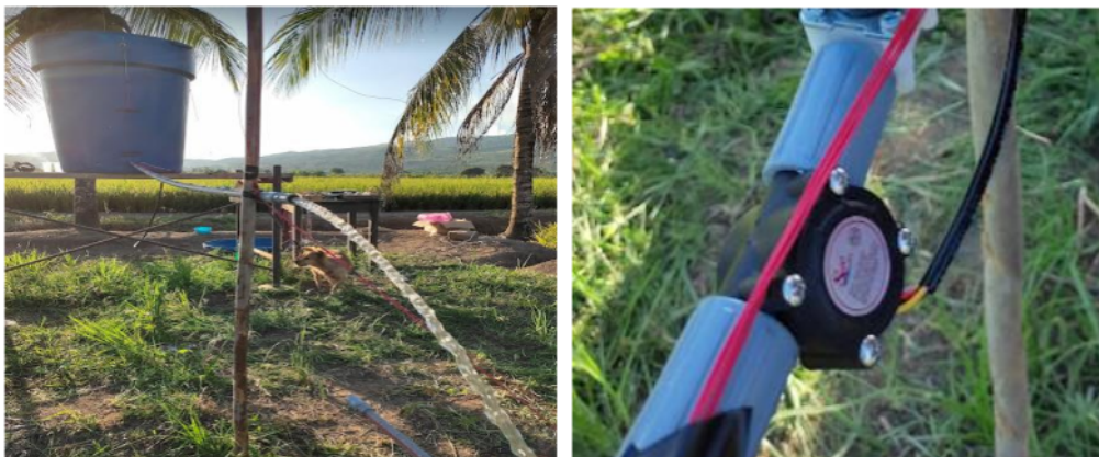
Figura 16. Instalación del sensor de flujo de agua (YF-S201)
