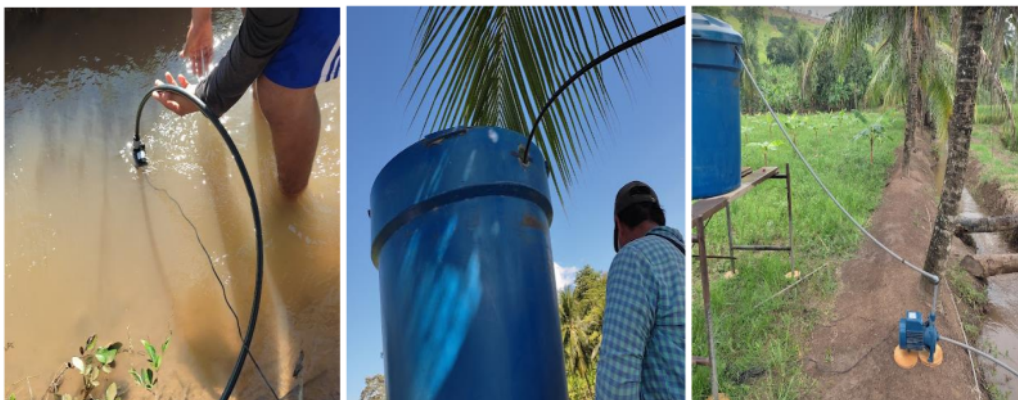
Figura 14. Instalación de la electrobomba
