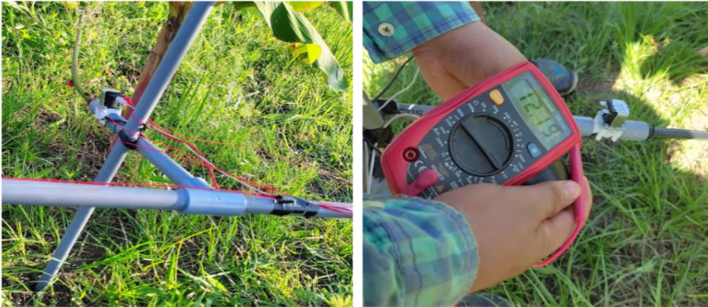
Figura 17. Instalación y testeo de las válvulas solenoide
