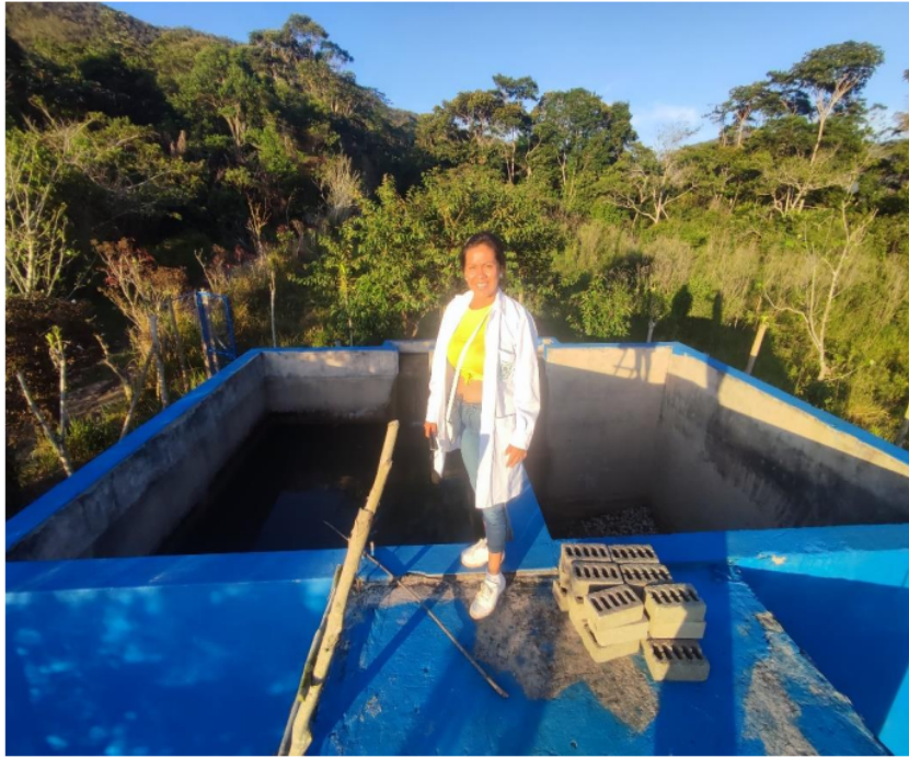
Fotografía 5. Breve inspección del reservorio
