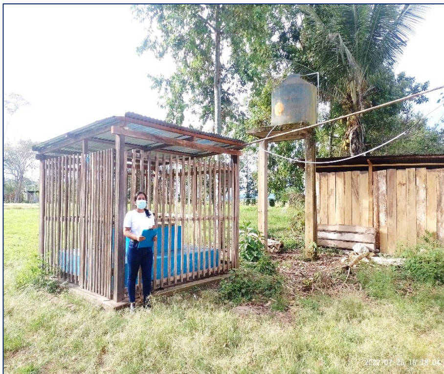
Foto 3. Sistema de abastecimiento de agua.
